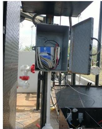
**Registro Fotográfico No 9.** Actividad de instalación y configuración de computador de flujo en el patín de medición.
