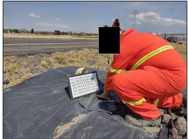
08. Las incisiones realizadas en la membrana de polietileno de alta densidad fueron debidamente selladas a fin de evitar la dispersión de gases.
