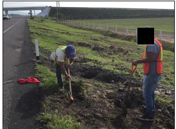
02. La construcción de la barrera de contención (zanja) se realizó con apoyo de recurso humano.
