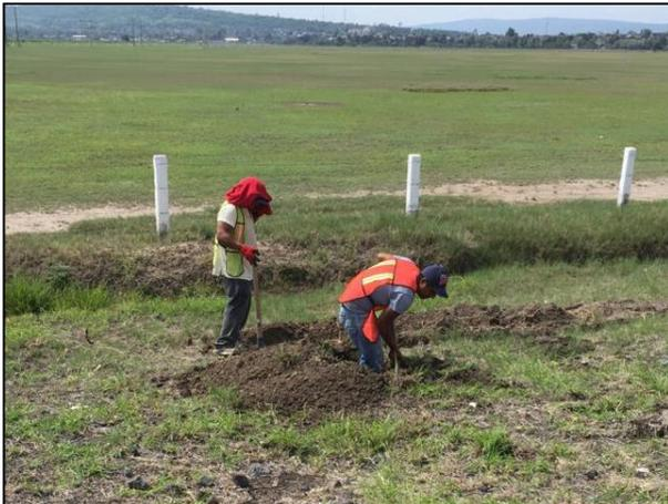
01. En el sitio se realizó la construcción de una barrera de contención (zanja) alrededor del Área Afectada a fin de mitigar el desplazamiento del hidrocarburo.
