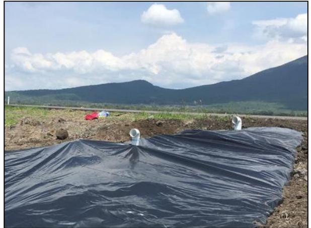
08. Se realizó la colocación de filtros de carbón activado para la captación de gases.
