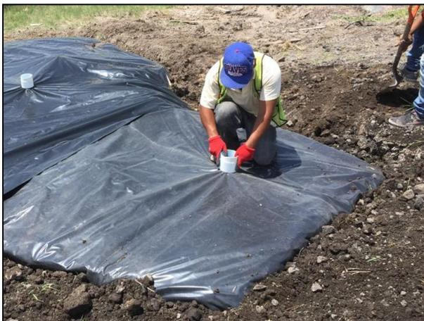
05. De manera manual se instalaron filtros de carbón activado dentro del Área Afectada.
