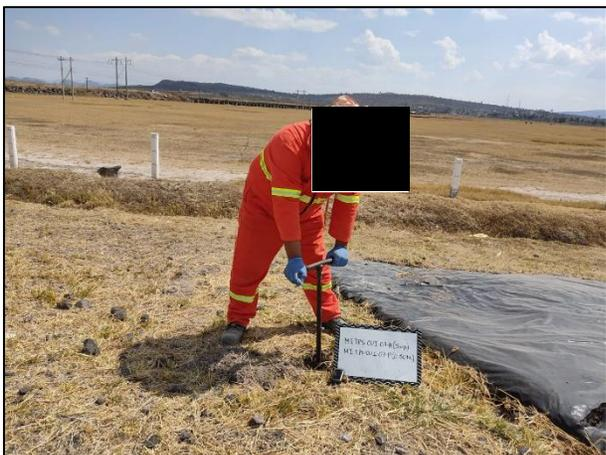
11. Con apoyo del Hand Auger se realizó la toma de muestras en las periferias del Área Afectada.
