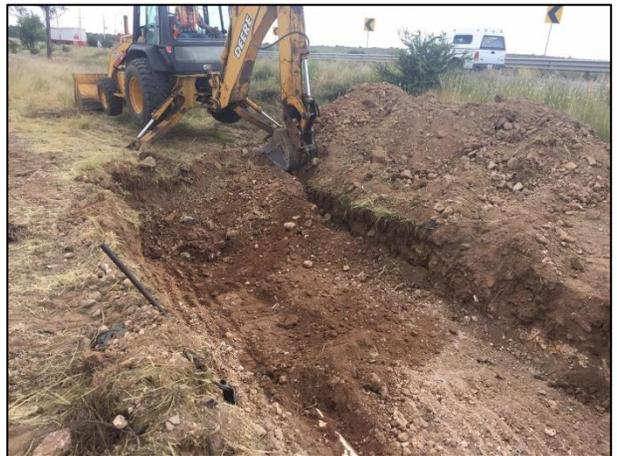
06. Con apoyo de retroexcavadora se realizó la extracción del material edáfico afectado.
