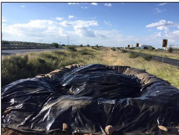
11. El material edáfico colocado dentro de la celda provisional fue cubierto con película de polietileno de alta densidad para evitar su dispersión.
