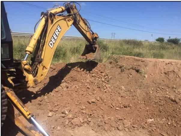
03. Se realizó la construcción de los bordos perimetrales de la celda provisional con ayuda de retroexcavadora.
