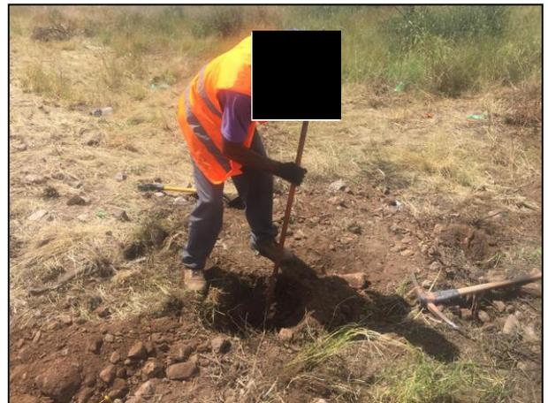
04. Con apoyo de una barra metálica se realizó el ablandamiento del suelo para la realización de sondeos.
