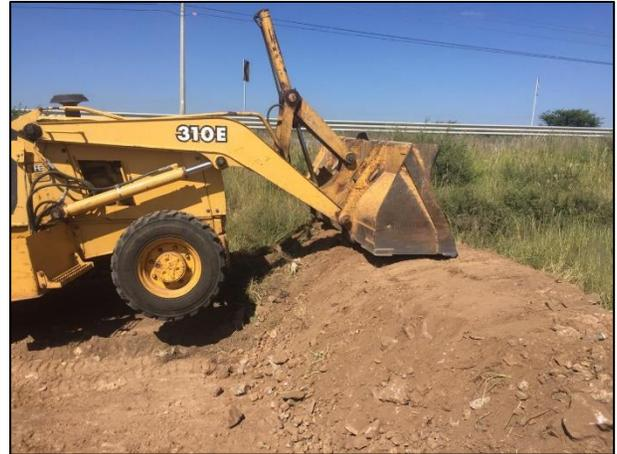
04. Con apoyo de retroexcavadora se llevó a cabo la compactación de los bordos perimetrales.
