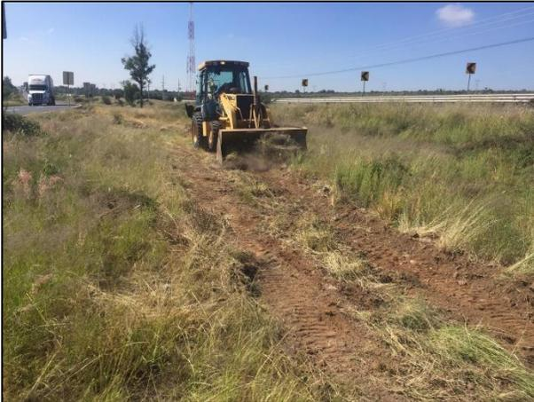
01. Con apoyo de retroexcavadora se realizó el acondicionamiento del sitio para la construcción de la calda provisional.
