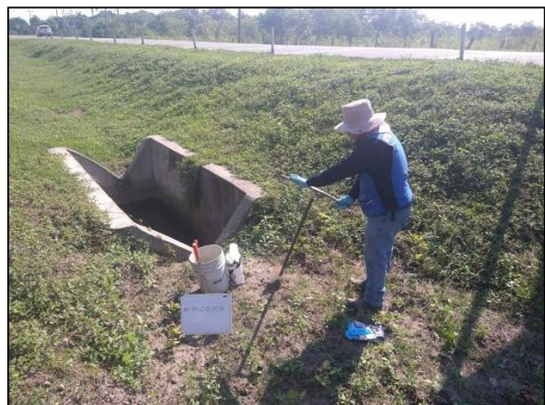
6. Se utilizó Hand Auger de acero inoxidable para la toma de muestra en la Fosa de Excavación.
