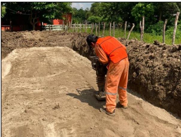
5. Compactación de la capa de arcilla, utilizando un vibro compactador manual.
