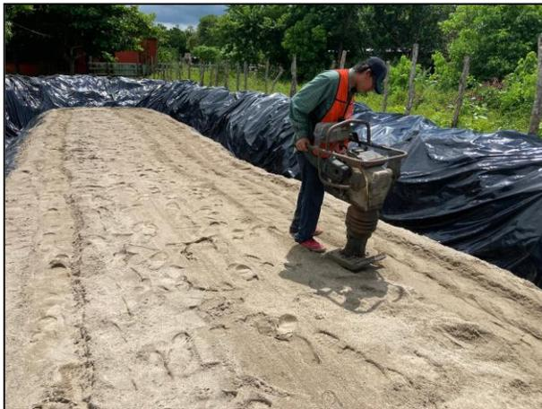
9. Con apoyo de recurso humano y de un vibro compactador manual, se realizó la compactación de la capa de arcilla.
