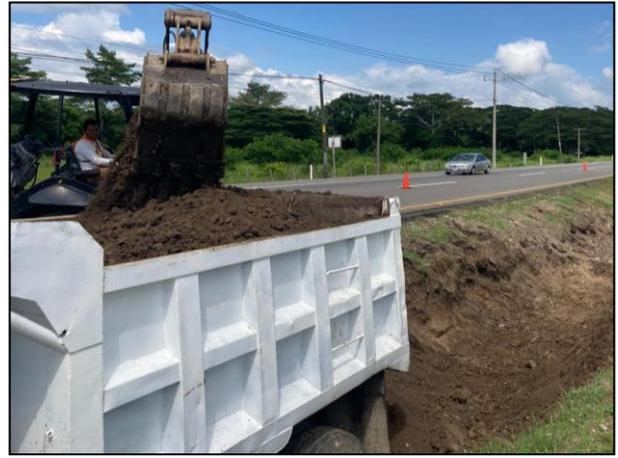
14. Con apoyo de retroexcavadora, se extrajo el material edáfico, colocándolo seguidamente en camión de volteo.
