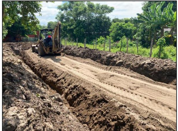
4. Con apoyo de retroexcavadora se colocó una capa de arcilla en la base de la celda provisional.
