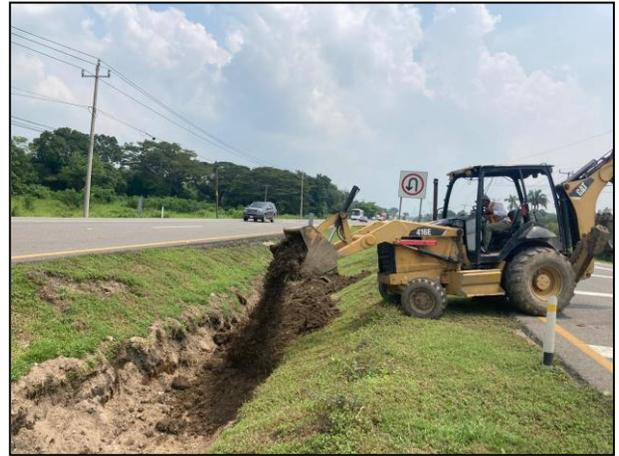
20. Con apoyo de retroexcavadora se procedió al relleno de la Fosa de Excavación.
