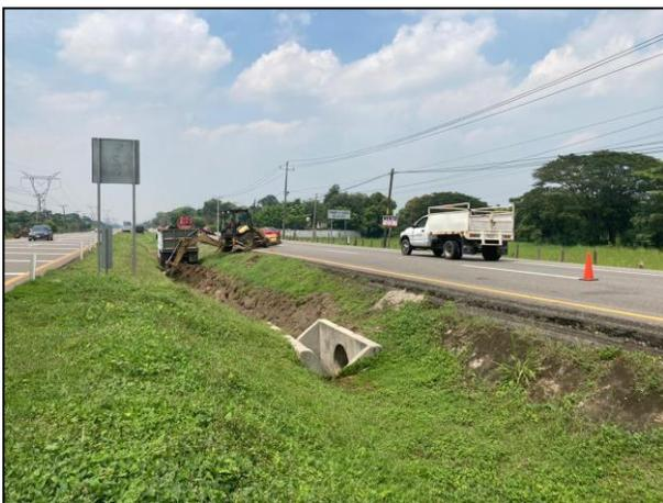
11. El material edáfico extraído fue acarreado a la celda provisional con apoyo de un camión volteo.
