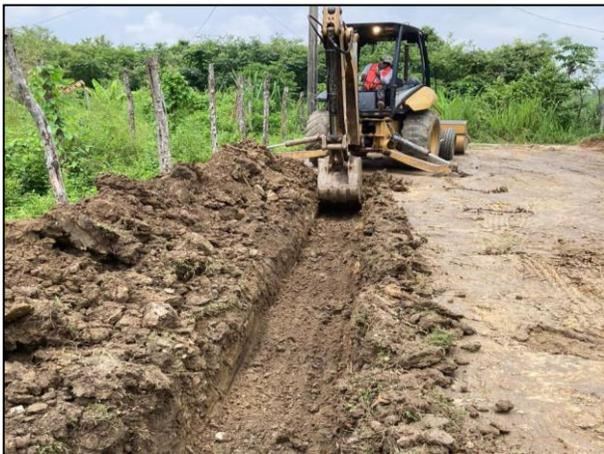
3. A la celda provisional se le construyeron los bordos y canaleta para la captación de lixiviados.
