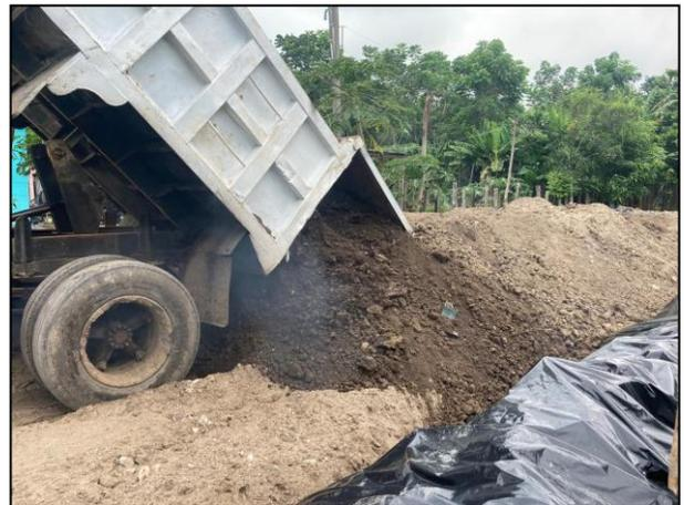
16. Acarreo y depósito del material edáfico en la celda provisional construida.
