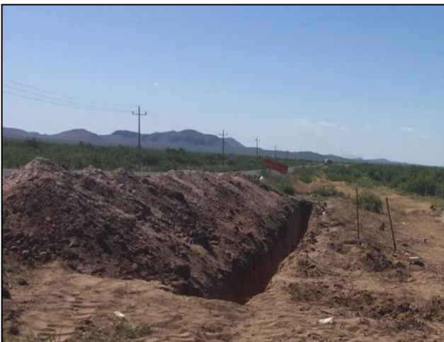
5. Toda el área afectada fue sometida a labores de emergencia, realizando zanja perimetral para la barrera de contención.
