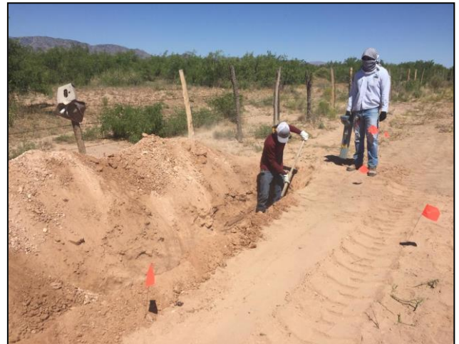
4. Construcción de una zanja para elaborar la barrera de contención.
