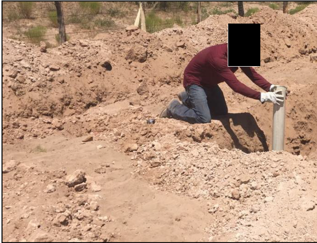
7. Colocación de filtros de carbón activado, en el área afectada por la Gasolina derramada.
