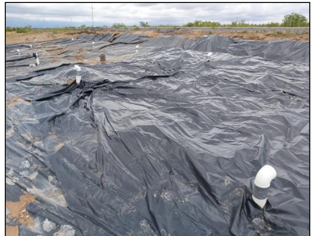
10. Vista del área sometida a labores de emergencia, con filtros de carbón activado y liner.
