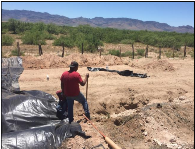
9. Se procedió a la colocación de liner para evitar transferencia suelo - atmósfera.
