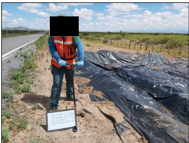
9. Toma de muestras a diversas profundidades en la periferia del área afectada, de acuerdo con el plan de muestreo.
