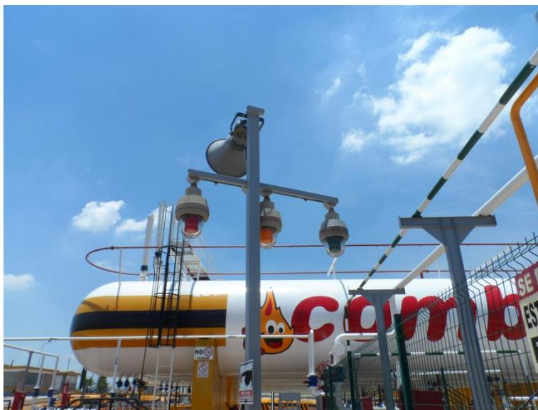
Figura 48. Alarmas sonoras y visuales del área de tanques de almacenamiento de Gas L.P.
