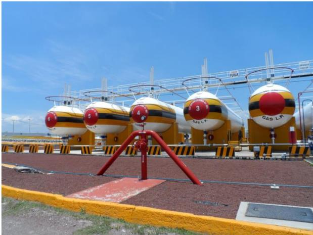
Tubería de rociado en cada tanque, con boquillas de aspersión
