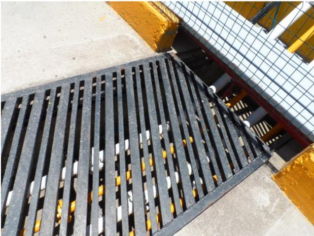
*Trinchera para tuberías*
