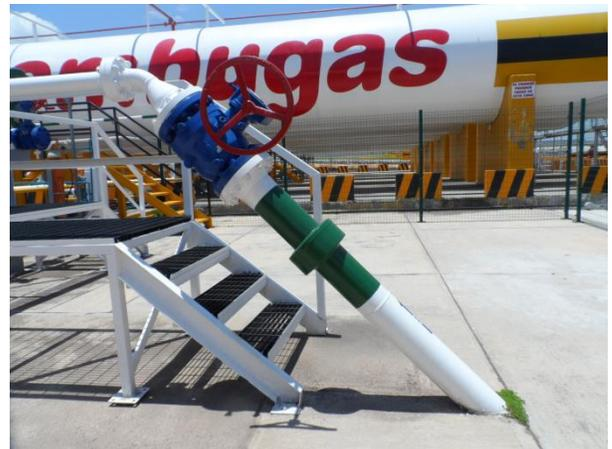
*Patín de Recibo y Medición. Junta monoblock (color verde) y válvula de corte con maneral (azul), a la salida del Gasoducto de 6" de diámetro.*
