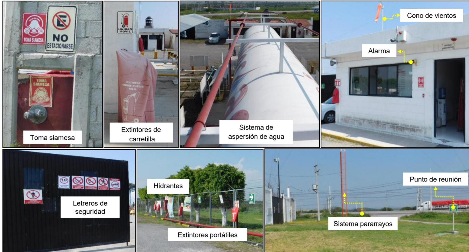
El equipo contra-incendio con el que se cuenta actualmente en la planta de distribución están los extintores portátiles y de carretilla, hidrantes, extintores, sistema de aspersion de agua, sistema pararrayos, alarma, letreros de seguridad y punto de reunión.
