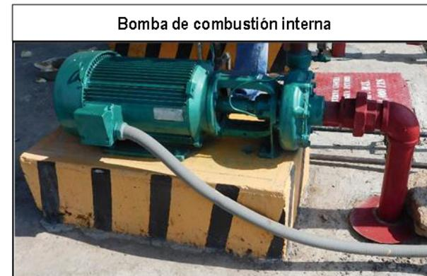
En las instalaciones de la planta de distribución se cuenta con una caseta para resguardo del equipo contra incendio, incluyendo 1 cisterna de 41,000 L. Con la ampliación pretendida se construirá otra cisterna de 50,000 L a la cual se le adaptarán las bombas con las que cuenta actualmente la planta. La bomba principal contará con un motor eléctrico de 30 HP marca Dreming Crane. La bomba de respaldo cuenta con un motor de combustión interna de 45 HP marca Barnes.
