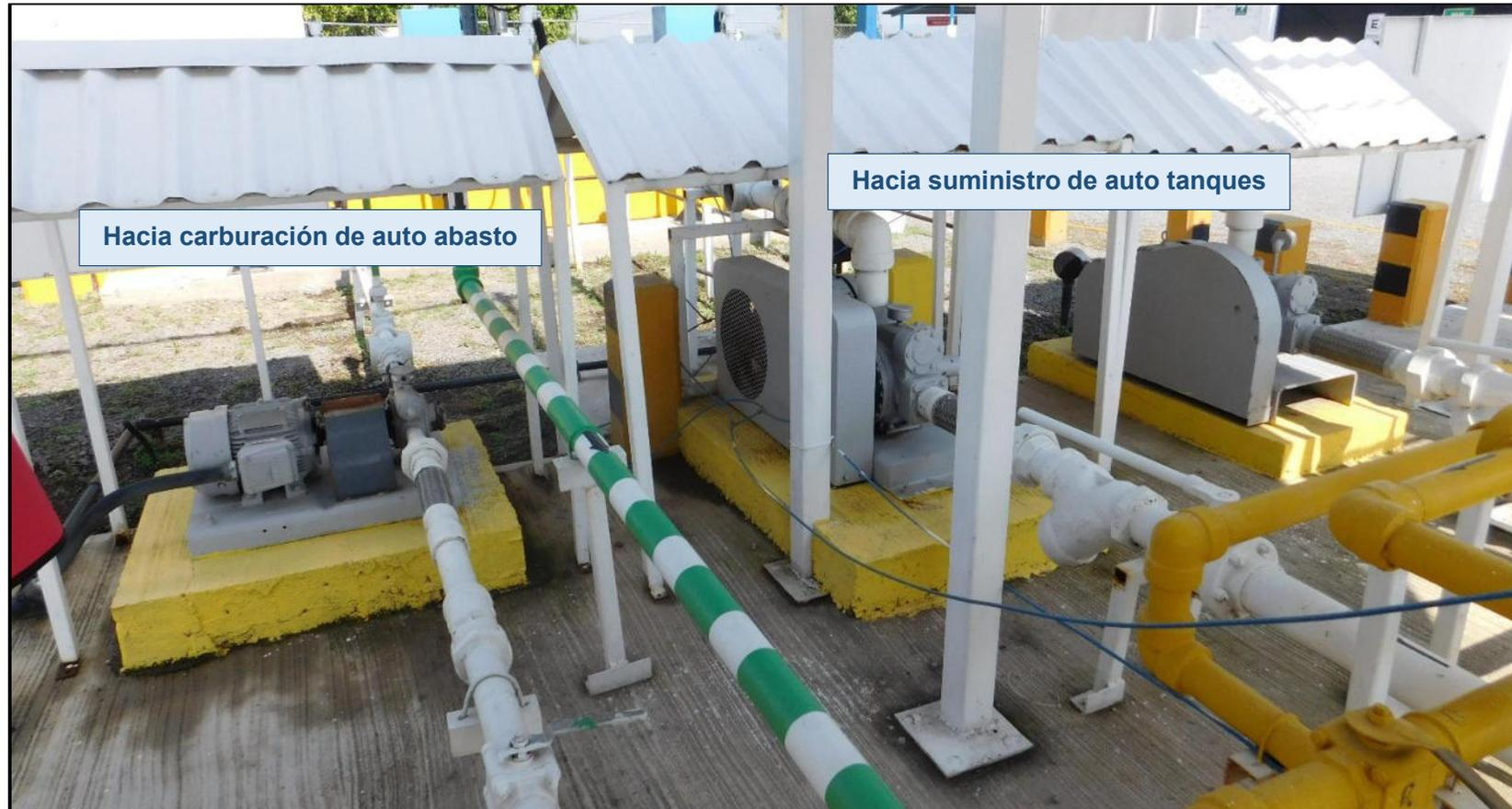
Para el suministro de GLP a diferentes medios (auto tanques y tanques de carburación), la planta cuenta con 3 bombas. La bomba I y II son para el llenado de auto tanques. Marca Blackmer modelo LGLD3 de 10 HP de potencia para una capacidad de 378 L/min. La bomba III para el servicio de llenado de tanques montados en vehículos propiedad de la empresa. Marca Blackmer modelo LGL 1.5 de 3 HP de potencia para una capacidad de 124.9 L/min.
