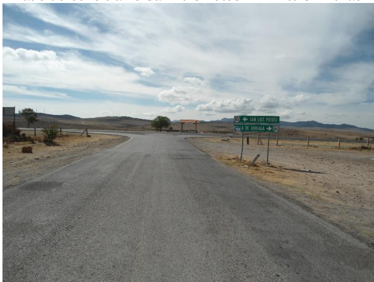
Fotografía 1. Vista de la Carretera San Luis Potosí – Lagos de Moreno (MEX-80) km 33+160, lado derecho tramo San Luis Potosí – Limite S.L.P/Zac
