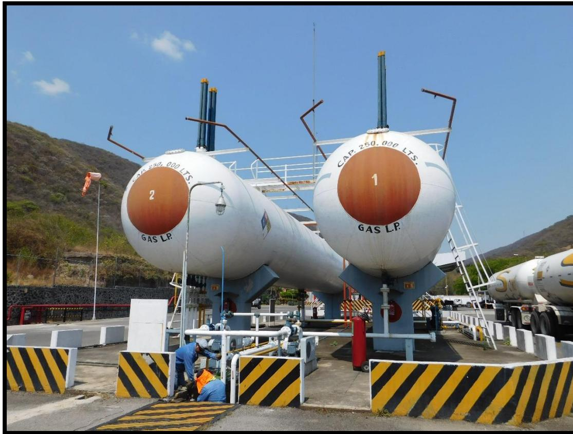
La capacidad de almacenamiento de la planta de distribución de Gas L.P., es 500,000 litros distribuidos en dos tanques de almacenamiento de 250,000 litros al 100% agua.
