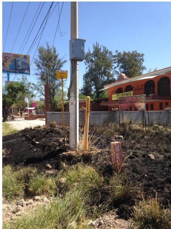
*Ilustración 26.- Señalamiento de línea de fibra óptica subterránea*
