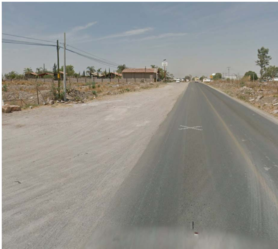
Fotografía 2. Vista Boulevard Juárez
