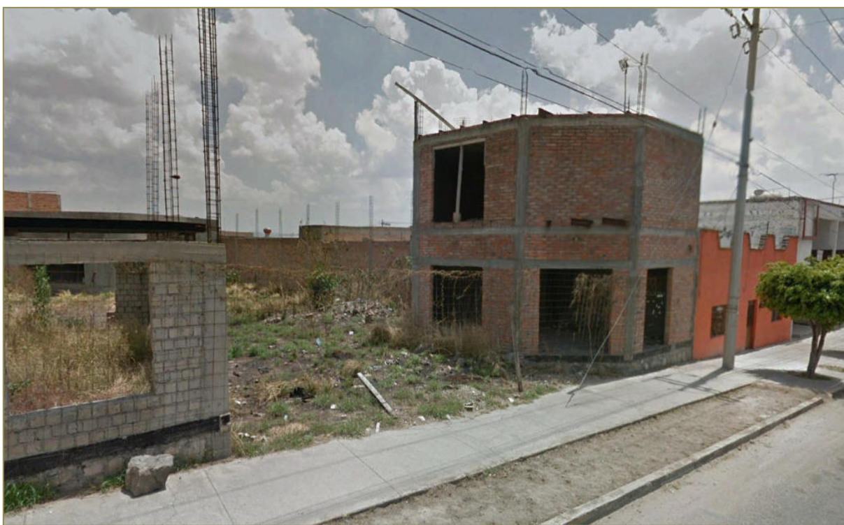
Fincas en construcción abandonadas
