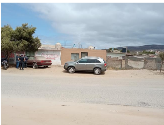
Foto 1.- Muestra el colindante hacia el norte del predio y que corresponde a zona habitacional.
