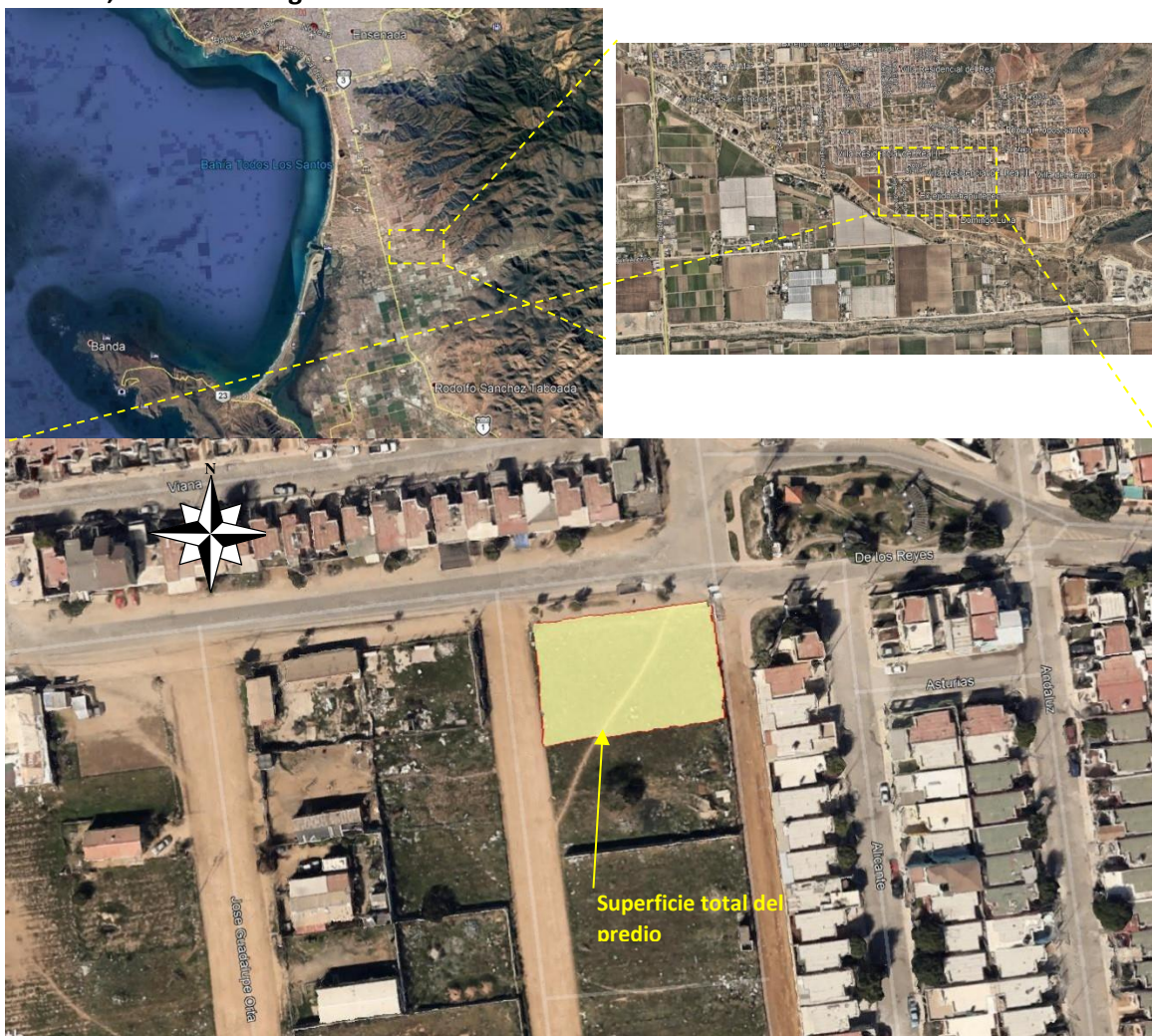
Figura 1.- Localización del predio de interés.
