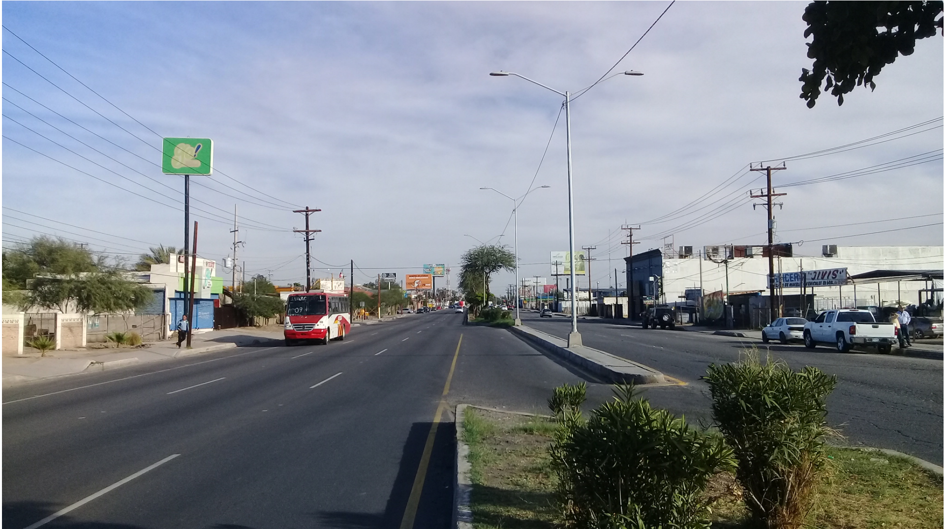
Foto 15 Vista de la Unidad Paisajista identificada en el AI en donde pretende insertarse el proyecto, predomina la infraestructura urbana, la cual se extiende más allá del alcance visual del espectador, la carencia de elementos naturales denota el grado de perturbación que tiene el AI, por lo que se caracteriza por una baja calidad paisajista y un escaso nivel de confort.
