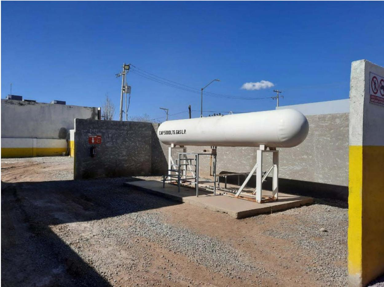
**Foto 5** Vista del área de Almacenamiento, pegado a la actual plancha de concreto se habilitara, otra más, para el nuevo tanque. La superficie se encuentra totalmente compactado y cubierto de gravilla, lo que permite la infiltración del agua; así mismo, se puede notar la casi nula presencia de estrato herbáceo.
