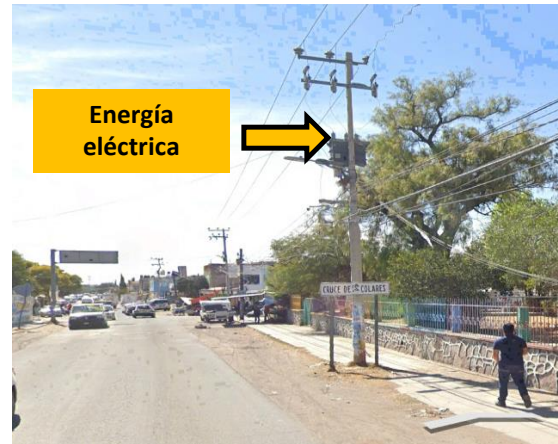
Foto 10- Energía eléctrica sobre Av. General Ignacio Beteta.
