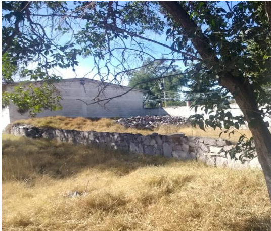
Foto 5- Construcción en desuso en el interior del predio en la colindancia Poniente.
