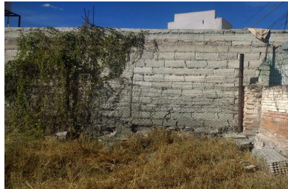
Foto 2- Interior del predio. Colindancia Poniente
