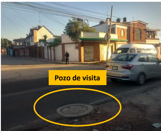
Foto 11- Pozo de visita sobre la Av. General Ignacio Beteta.
