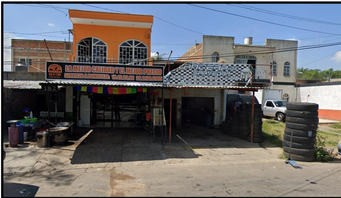
FOTOGRAFÍA 14. CARNICERÍA Y SERVICIO DE LLANTERA A 191.63 METROS LINEALES APROX. AL OESTE.
