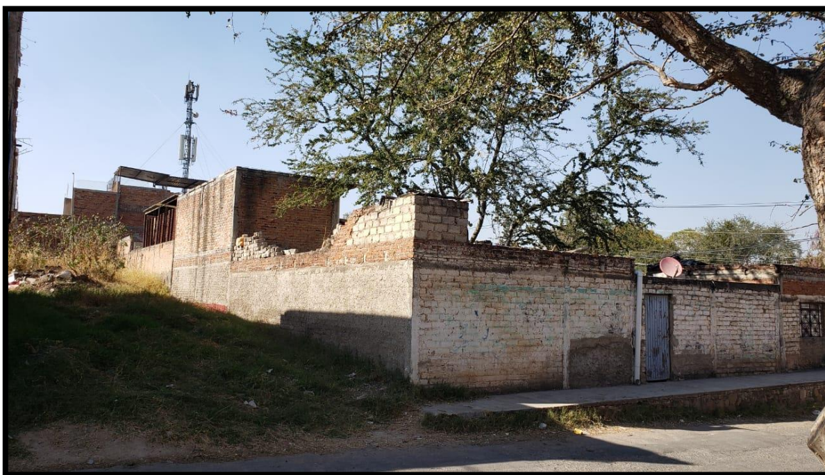
FOTOGRAFÍA 36. SITIO DEL PROYECTO.
