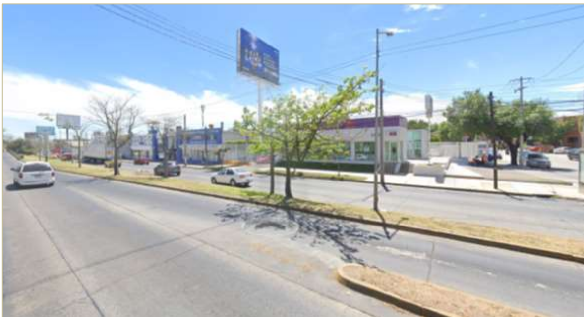
Vista de la Calz. Lázaro Cárdenas, en donde se aprecian los cuerpos viales con los que cuenta, así como banquetas y alumbrado público.
