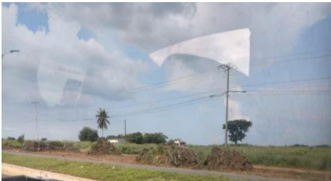
Imagen 52. Vista del retiro de vegetación en una pequeña parte colindante a la carretera para dar mejor acceso al terreno.
