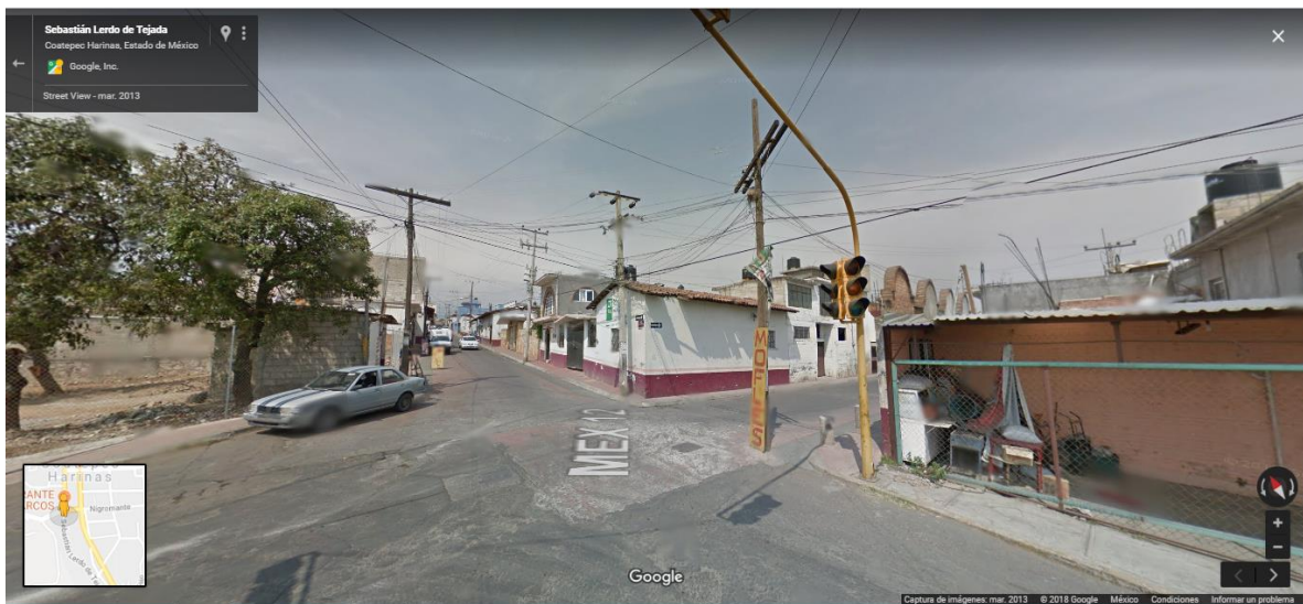
Fotografía No. 7. Vista norte. El Área de Influencia donde se localiza la estación de servicio se encuentra provista de los servicios: eléctrico, agua potable y drenaje como se muestra en la imagen.
