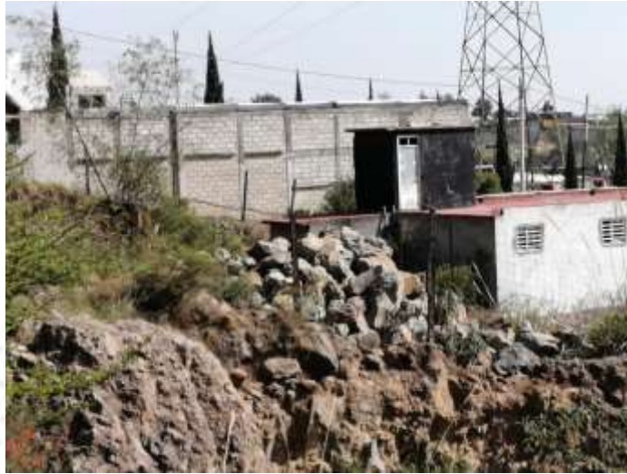
Fotografía No. 7. Construcción existente que será demolida durante los trabajos constructivos y rocas acumuladas dentro del predio del proyecto.
