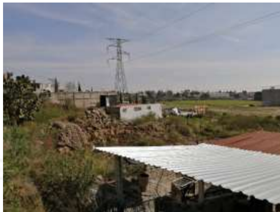
Fotografía No. 6. Vista al norte del predio del proyecto, se aprecia construcción existente que será demolida durante los trabajos constructivos y rocas acumuladas dentro del predio. Se aprecia nopalera ubicada fuera del predio del proyecto.
