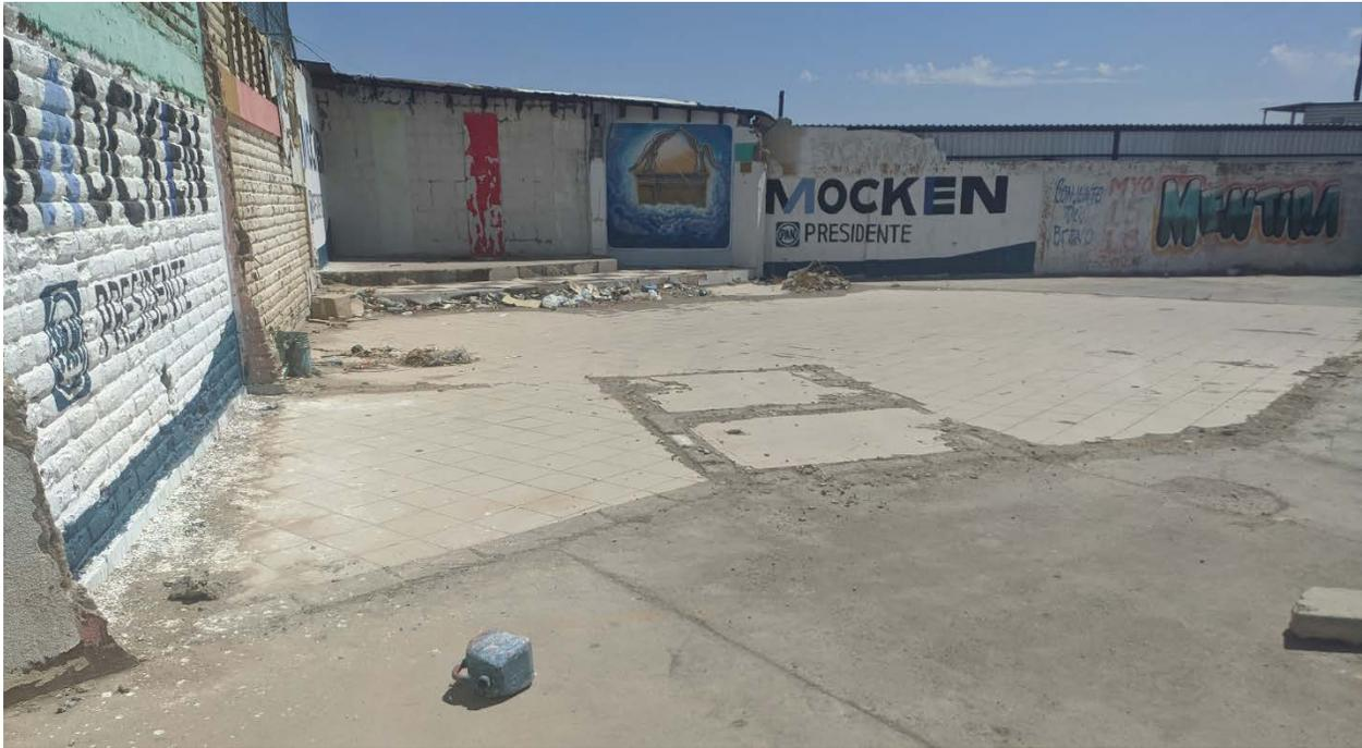
**Foto 3** Vista de las condiciones actuales del predio, como se puede observar el piso cuenta con recubrimiento de loseta y al fondo hay un desnivel formado por un par de escalones, esta superficie se valora si es útil para el proyecto, de no ser el caso será demolida, para tener una superficie pareja, todo esto será retirado con el fin de nivelar y unificar el suelo dentro de la estación.
