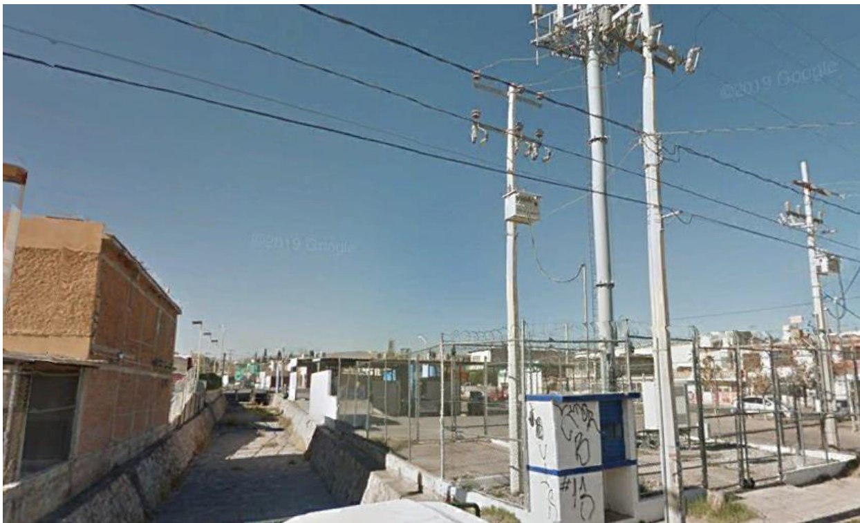
Foto 7 Vista del recubrimiento de piedra y cemento que hicieron del escurrimiento que colinda con la estación, como se ve en la imagen, el arroyo es intermitente y únicamente lleva agua en temporada de lluvias, debido al recubrimiento no se prevén daños o inconvenientes por su cercanía con el proyecto.
