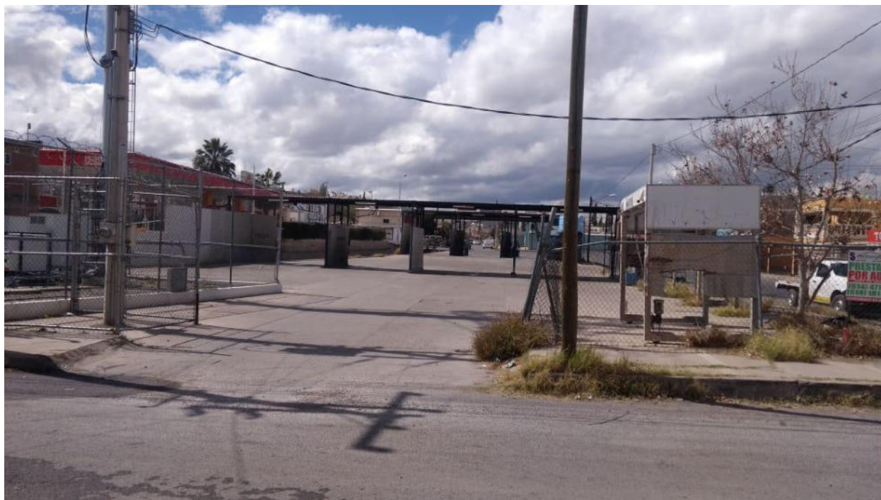
Foto 4 Actualmente la entrada al predio se ubica del lado de la Ponciano Arriaga, el predio se encuentra delimitado por malla ciclónica de 2.40 m de altura.
