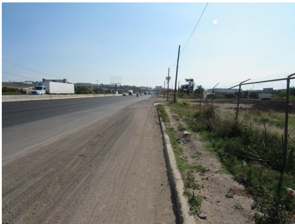
En la toma se puede apreciar el tramo carretero Silao – Irapuato.
