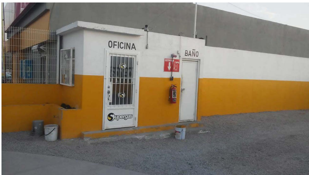
Foto 1 Vista de las construcciones de la estación: oficina y baños, éstos se ubican del lado Oeste a la salida del predio.
