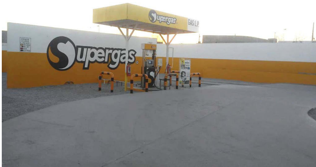
Foto 6 Condiciones actuales del suelo dentro del predio en el área de almacenamiento.
