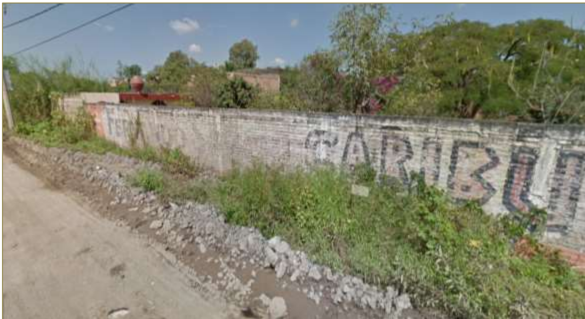
Foto III.1.a)-3. Vista desde Río Colorado, hacia la colindancia Este, en donde se aprecia una finca.
