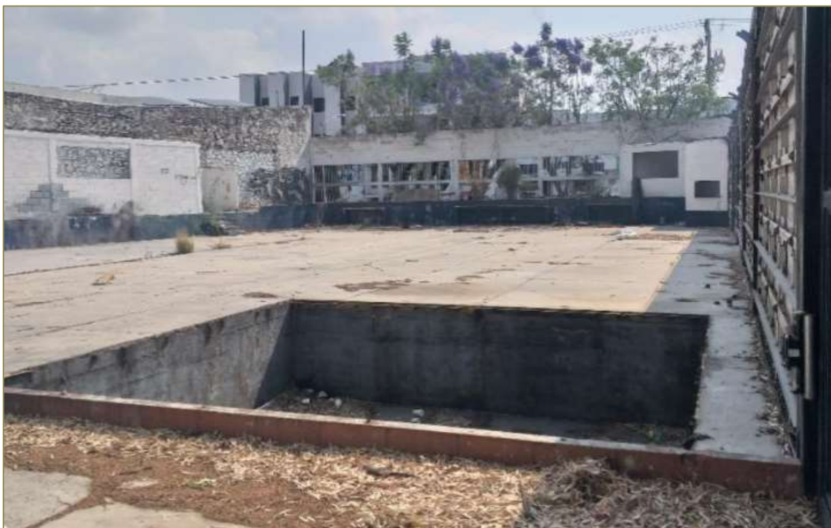
Vista hacia el interior del predio, en donde se aprecia la presencia de vegetación de tipo ruderal.
