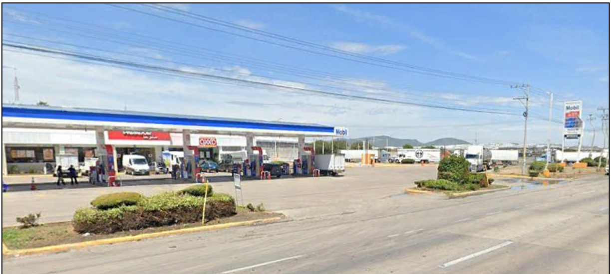
Figura 1. Vista lateral de la estación.
