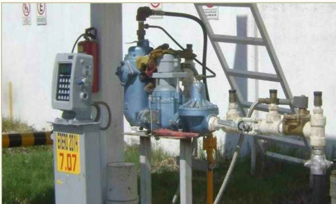
Figura III.1.c)-1. Dispensario doble para el Gas L.P.
