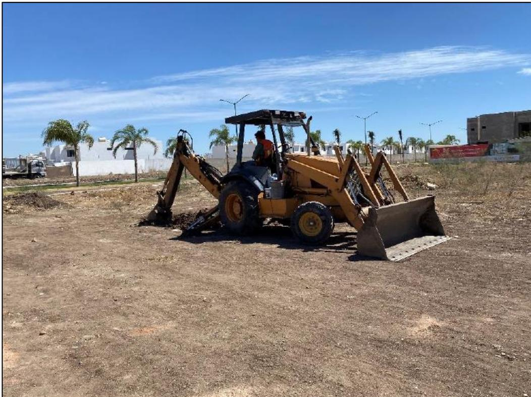
Fotografía 10. Realización del Pozo a Cielo Abierto PCA #1.
