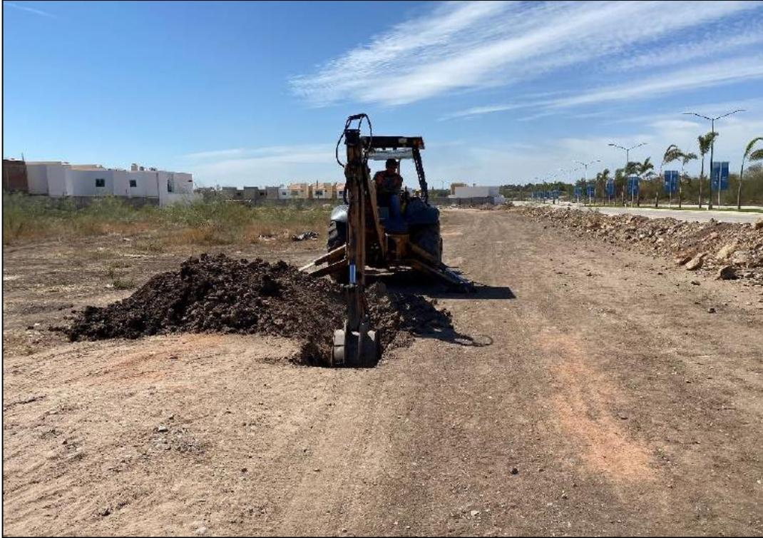
Fotografía 19. Realización del Pozo a Cielo Abierto PCA #4.
