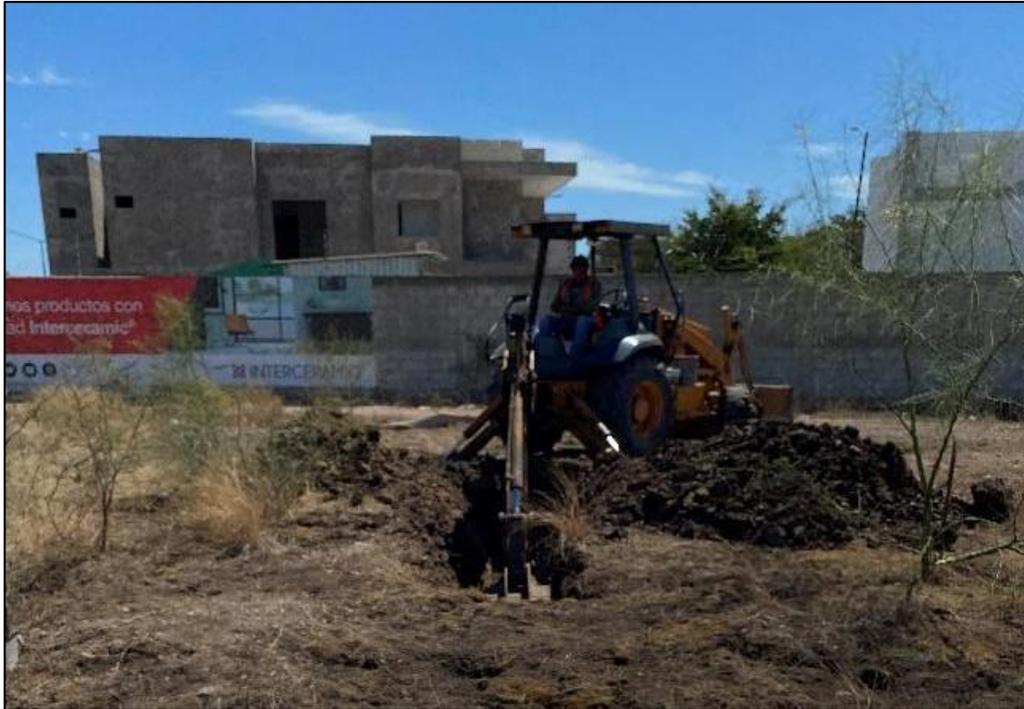
Fotografía 13. Realización del Pozo a Cielo Abierto PCA #2.
