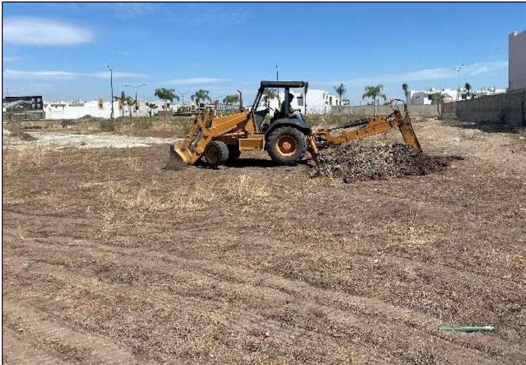
Fotografía 16. Realización del Pozo a Cielo Abierto PCA #3.
