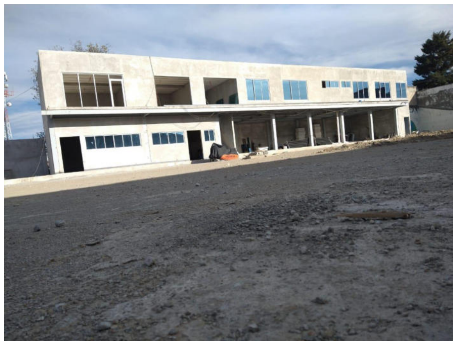
Vista Interior del Area de Oficinas
