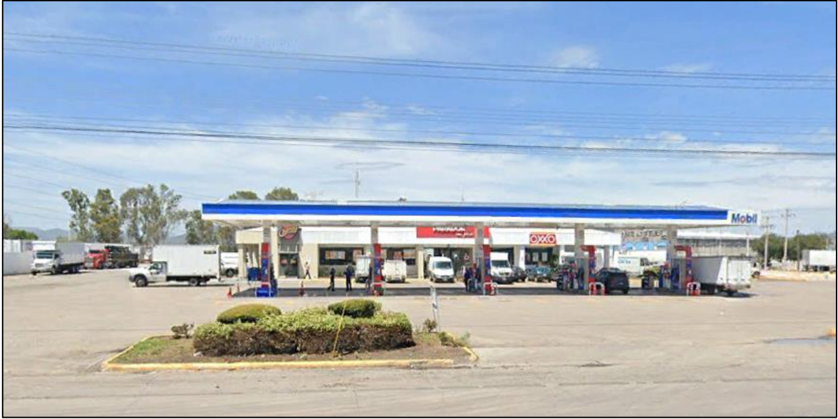
Figura 1. Vista general de la estación.
