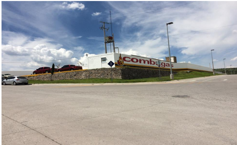
Figura 8. Vista general exterior de la Planta de Distribución de Gas L.P.
