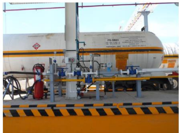
Figura 21. Cobertizo para recepción y suministro de semirremolques
