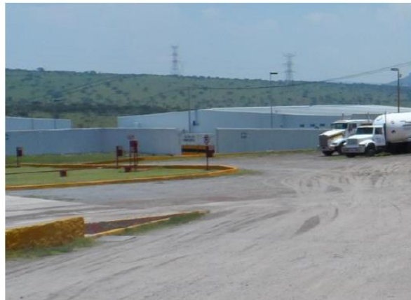
Figura 10. Salida de emergencia costado Este
