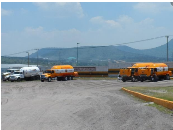
Figura 42. Estacionamiento para Autotankes de reparto
