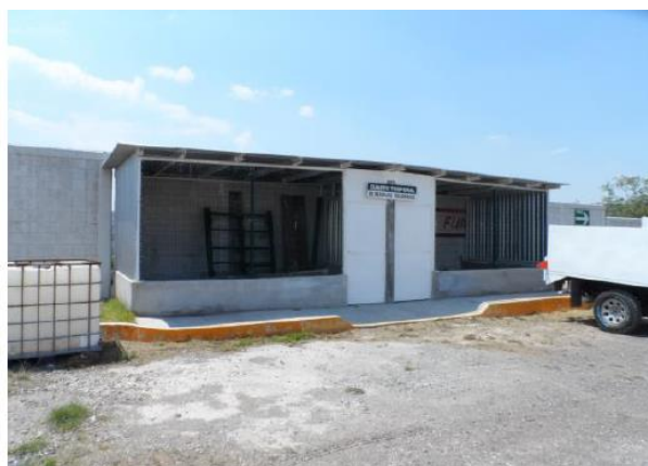
Figura 32. Almacén temporal de residuos peligrosos y área de acopio de residuos sólidos
