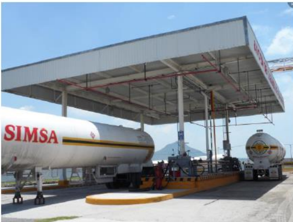
Figura 20. Cobertizo para recepción y suministro de semirremolques
