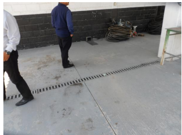
Figura 37. Taller de reparación de tractocamiones y semirremolques
