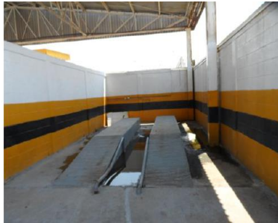
Figura 34. Taller de reparación de autotankes
