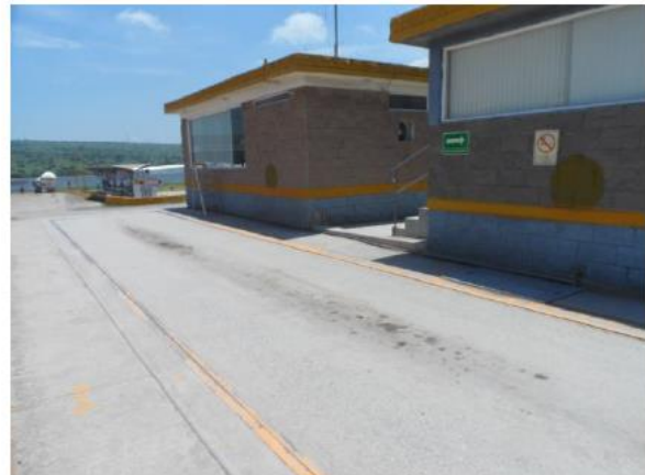
Figura 14. Cuarto de control, caseta y báscula para semirremolques
