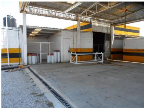
Figura 30. Almacén de refacciones para Autotanques y bodega
