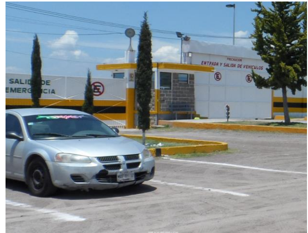
Figura 52. Caseta de vigilancia (Vista interior)
