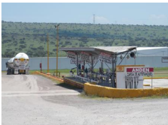
Figura 22. Cobertizo suministro a autotanques
