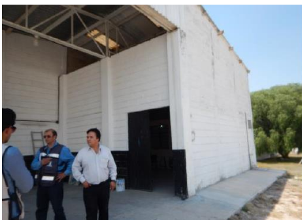
Figura 31. Almacén de refacciones para semirremolques
