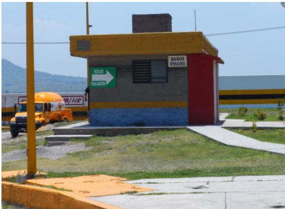
Figura 49. Servicios sanitarios para operadores de autotanques y semirremolques
