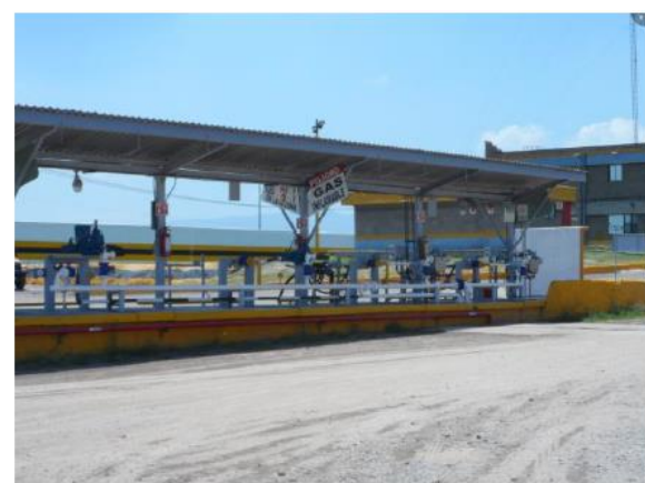
Figura 23. Cobertizo suministro a autotanques
