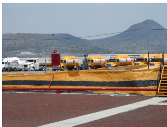
Figura 43. Estacionamiento para Autotankes de reparto
