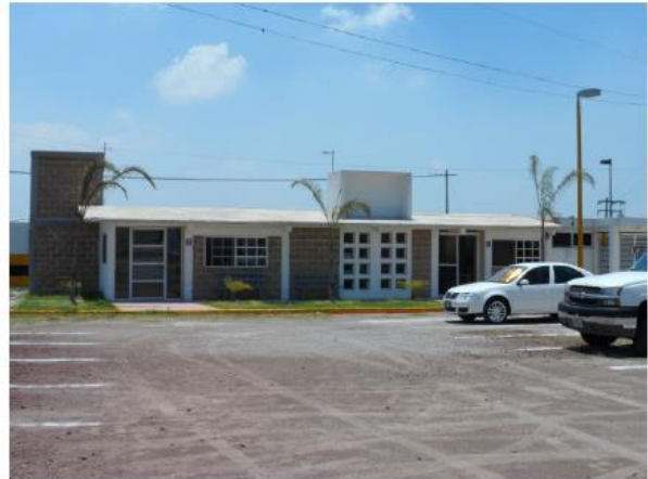
Figura 12. Área de comedor y sala de juntas-capacitación
