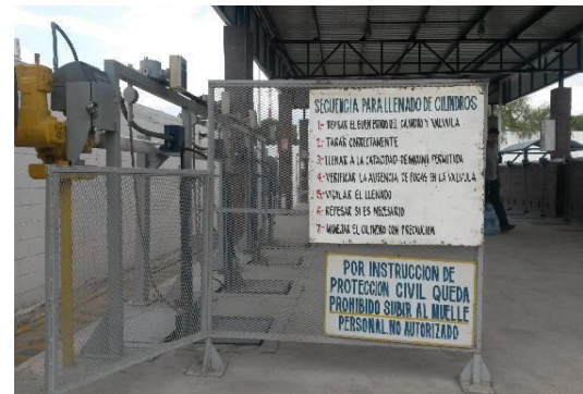
Imagen 13. Fotografías de equipo e instalaciones
