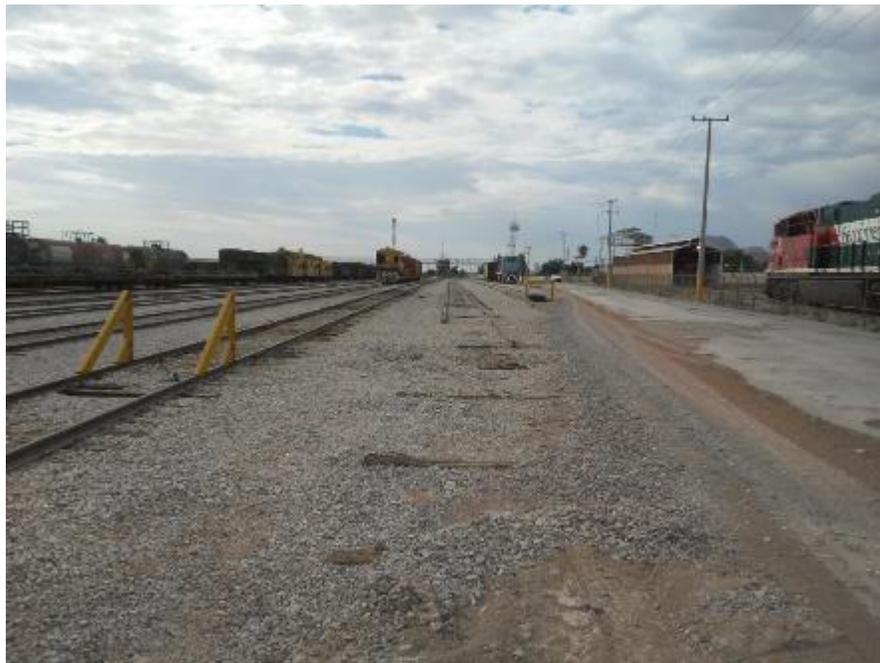
El terreno tiene una nivelación y compactación previa sobre la que han sido montados los terraplenes de balasto para la instalación de durmientes y rieles de FFCC.
