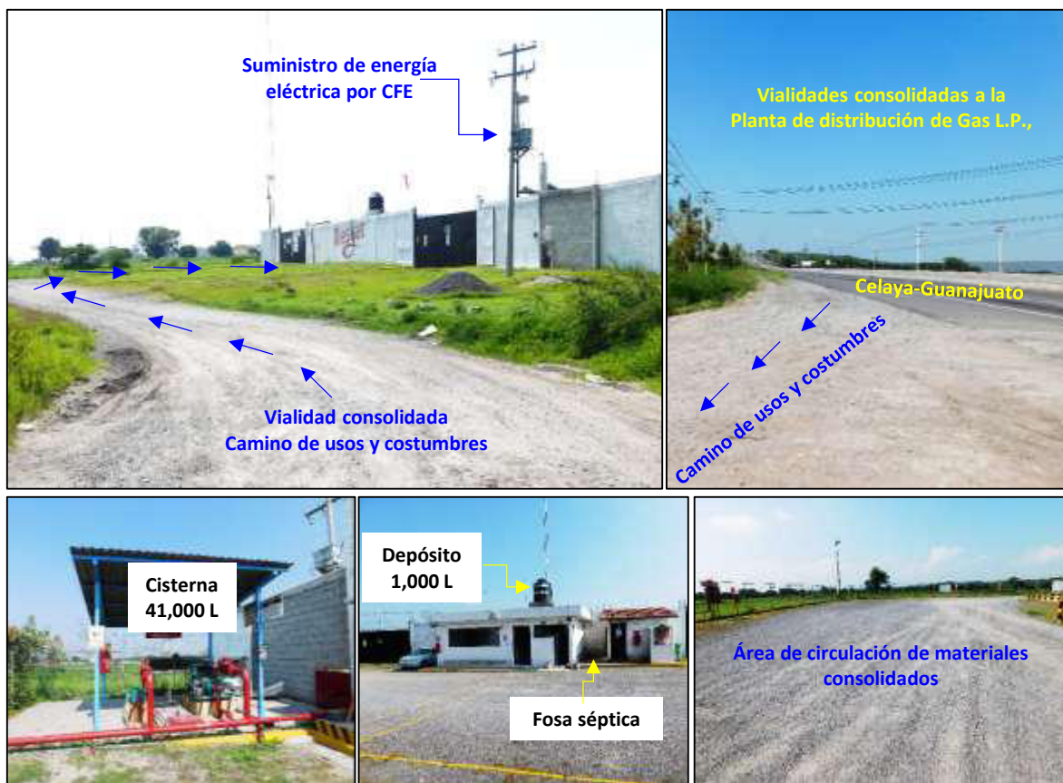
Figura II.11 Servicios urbanos en las instalaciones de la planta de distribución de Gas L.P.
