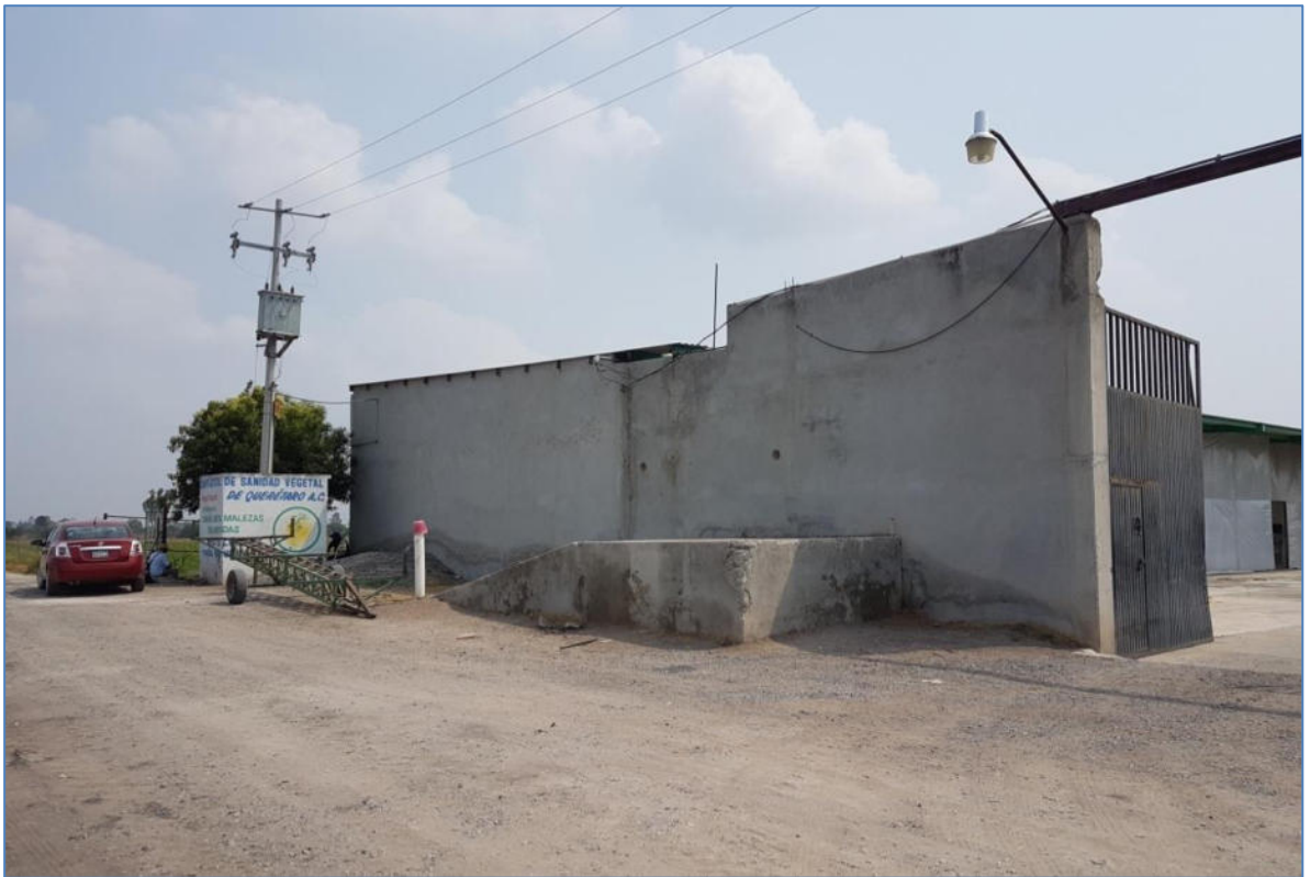
Vista del acceso a la finca que colinda con el predio en proyecto.
