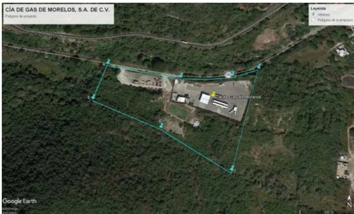
Figura 2.1. Ubicación de las coordenadas del predio, propiedad de COMPAÑÍA DE GAS DE MORELOS, S.A. DE C.V.
