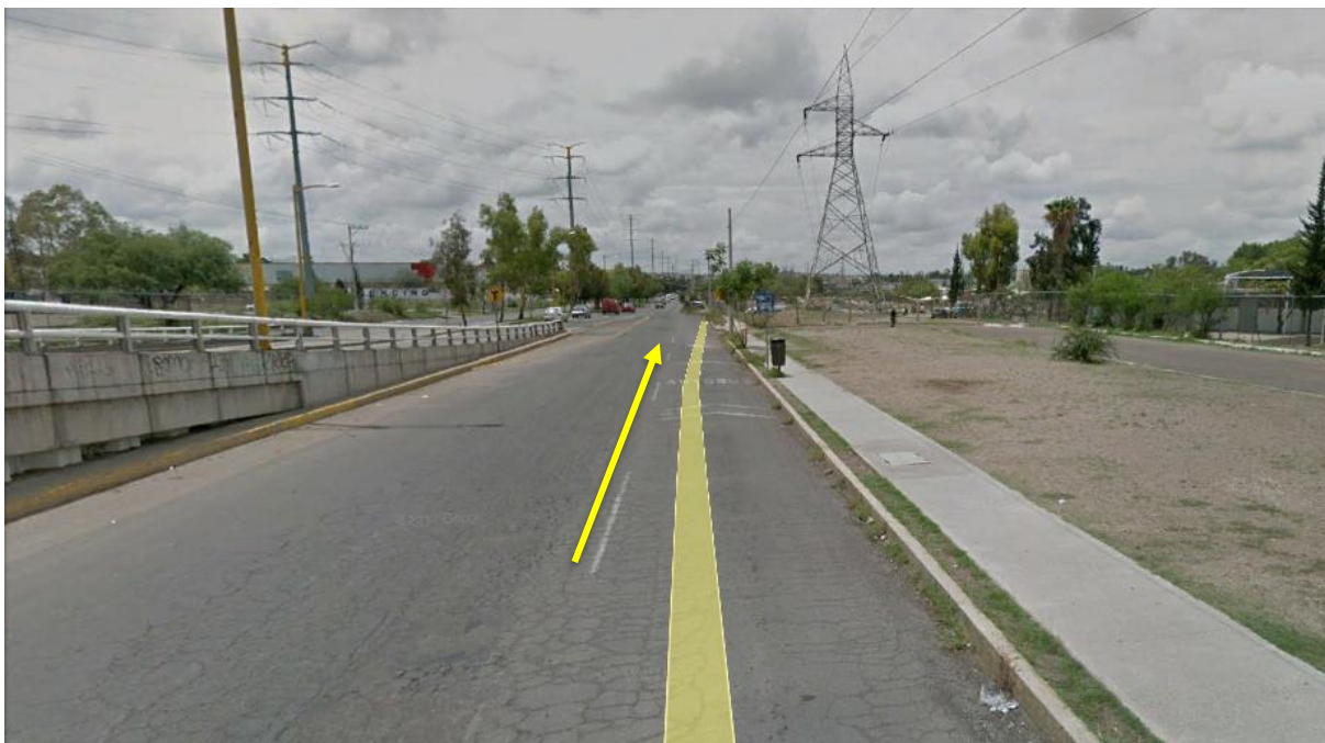
Figura 14. Vía de acceso; Av Aguascalientes Oriente
