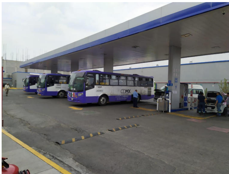
FIGURA 2. FOTOGRAFÍA DE LA ESTACIÓN DE SERVICIO.
