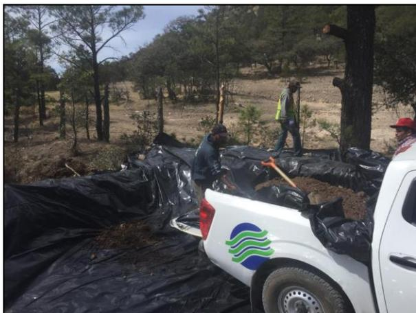
11. Acarreo y depósito de material extraído en la celda provisional, a la cual previamente se le colocó membrana de polietileno de alta densidad.
