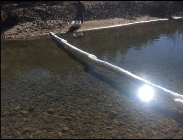
01. A fin de contener el derrame del hidrocarburo sobre el Arroyo Las Arañas, se colocaron cordones oleofílicos e hidrofóbicos.
