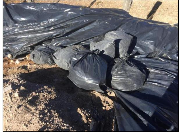
2. Los cordones oleofílicos e hidrofóbicos y los tapetes absorbentes se depositaron en Celda Provisional para su posterior envío a centro autorizado de servicios de almacenamiento y acopio de residuos peligrosos.
