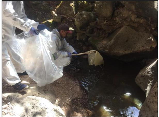
14. Los tapetes absorbentes se recolectaron en bolsa plástica impermeable, para su posterior depósito en celda provisional.
