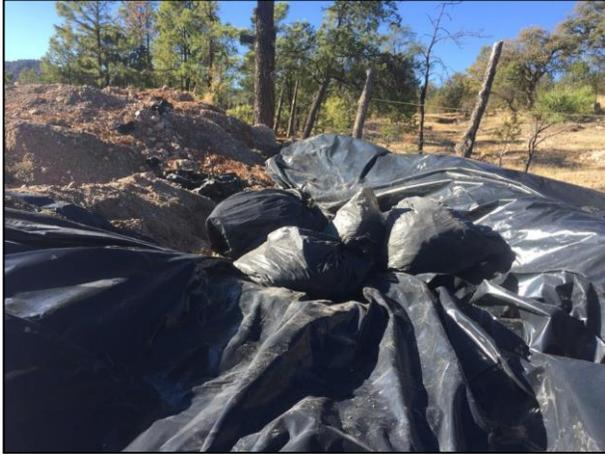
1. Los cordones oleofílicos e hidrofóbicos y los tapetes absorbentes colocados en el cauce del Arroyo afectado fueron recolectados y depositados en la Celda Provisional.
