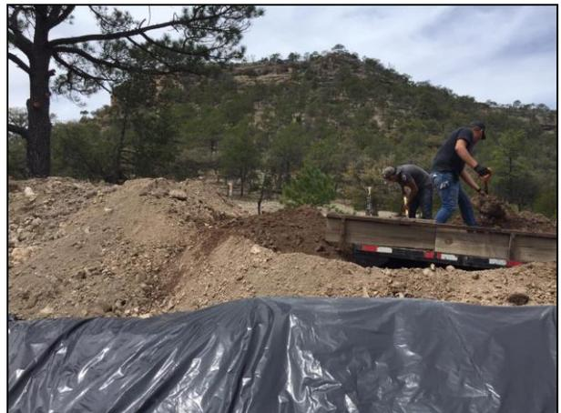
18. El material edáfico afectado fue extraído en su totalidad y depositado en celda provisional como parte de las Labores de Emergencia.
