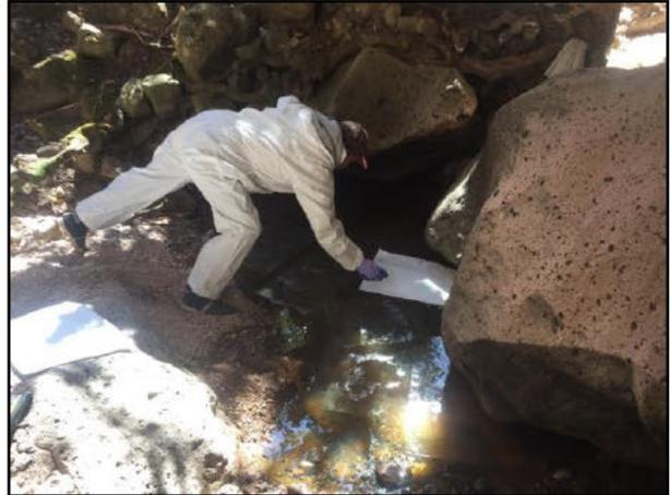
04. Se colocaron tapetes absorbentes en distintos puntos del cuerpo de agua afectado, a fin de evitar mayores afectaciones a partir del derrame del hidrocarburo.
