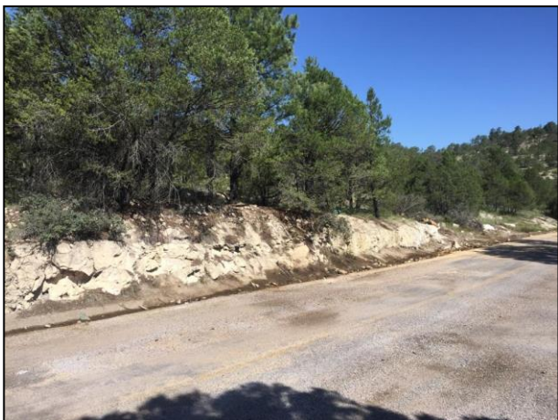
01 - El sitio de derrame se ubica a la altura del Km. 223 de la Carretera Federal No. 16, tramo Tomochi – Basaseachi, municipio de Guerrero, estado de Chihuahua.
