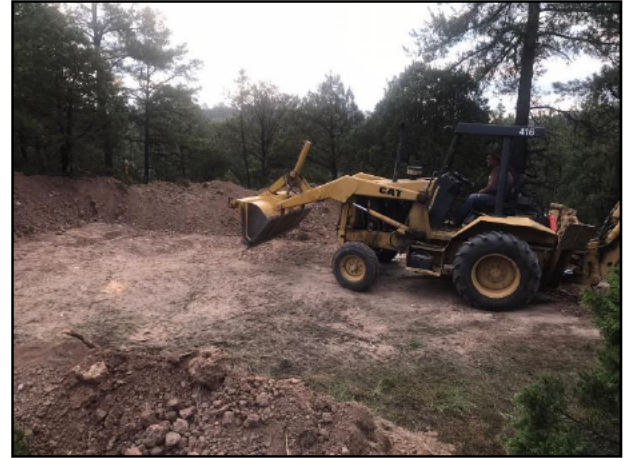
02 - Construcción de bordos de la Celda Provisional con apoyo de la retroexcavadora.
