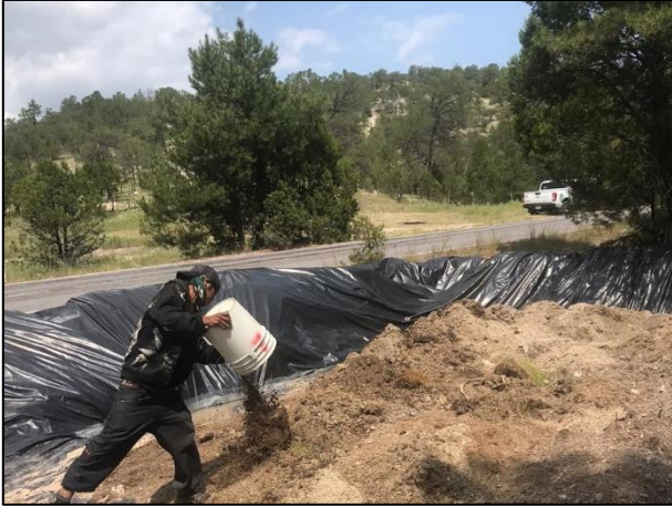
13 - El material edáfico extraído se depositó en la Celda Provisional.
