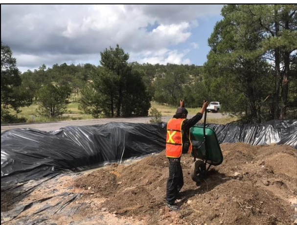
17 - Se realizó el depósito del material edáfico extraído en la Celda Provisional previamente construida.
