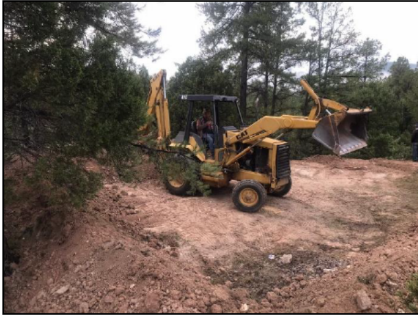
01 - Se realizó el acondicionamiento del sitio en el cual se construyó la Celda Provisional.
