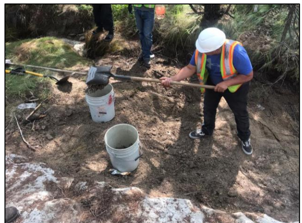
12 - En las Zonas afectadas del sitio se llevó a cabo la extracción del material edáfico afectado por el derrame de Diésel.
