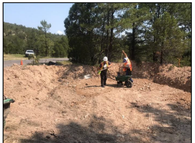
06 - Con apoyo de recurso humano se colocó una capa de arcilla sobre la base de la Celda Provisional.
