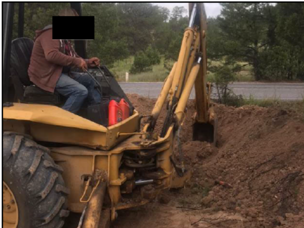
03 - Se definieron y se compactaron los bordos de la Celda Provisional con apoyo de la retroexcavadora.
