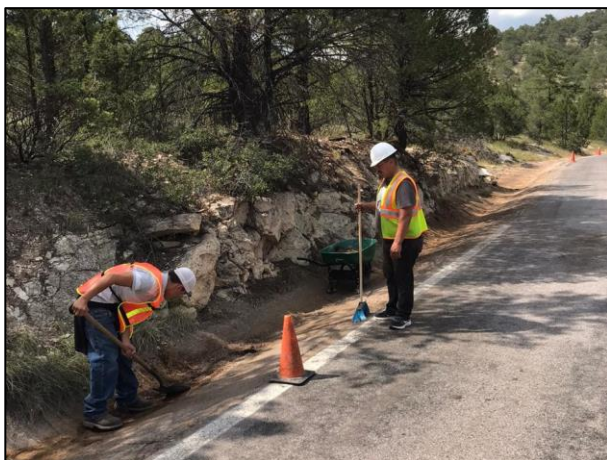
11 - Con ayuda de recurso humano se realizó la extracción del material edáfico afectado que quedó azolvado en las canaletas.
