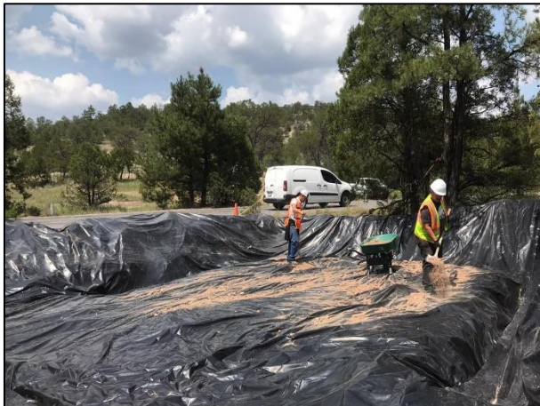
09 - Colocación de capa de arcilla sobre la Celda Provisional con apoyo de recurso humano.
