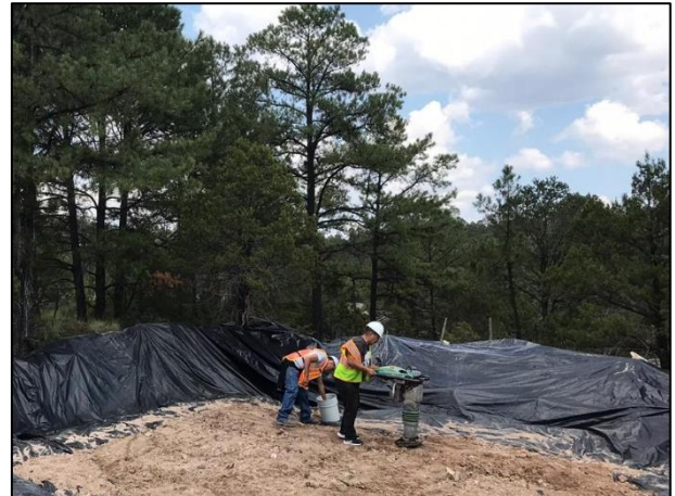
10 - Se llevó a cabo la compactación de la capa de arcilla con apoyo de vibro compactador manual.
