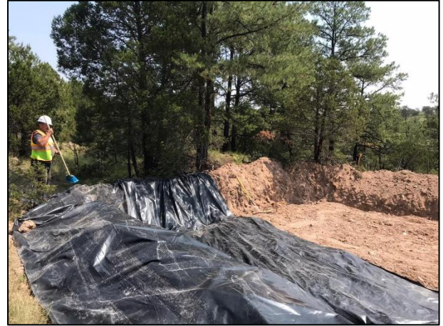
08 - Se cubrió la Celda Provisional con una película de polietileno de alta densidad.
