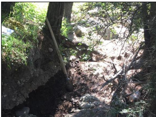
03 - Con apoyo de personal de campo se realizaron sondeos en el sitio en estudio con el fin de conocer la infiltración de Diésel en el suelo natural.
