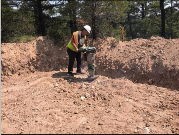
07 - Compactación de la capa de arcilla con el apoyo de vibro compactador manual.
