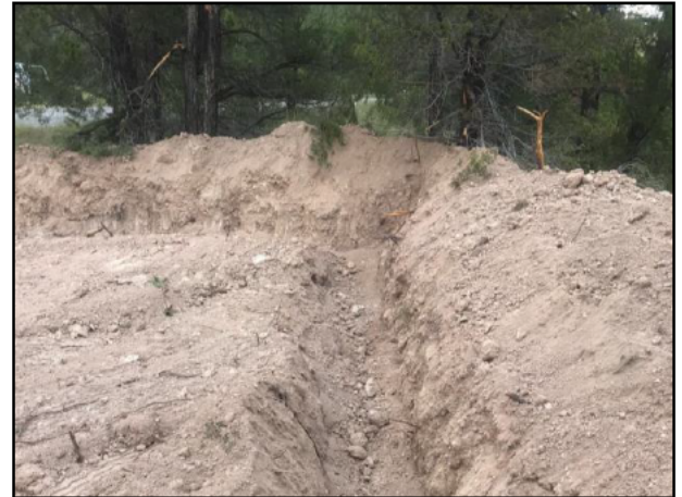
04 - Construcción de canaletas para captación de lixiviados de la Celda Provisional.
