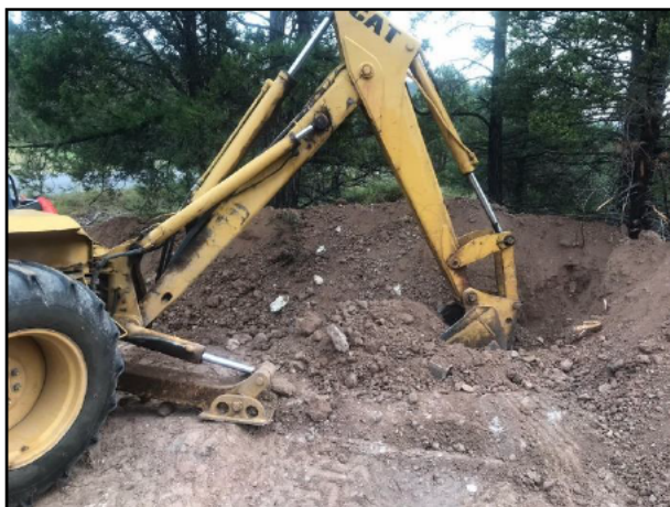
05 - Se realizó la construcción de un cárcamo para la captación de lixiviados.
