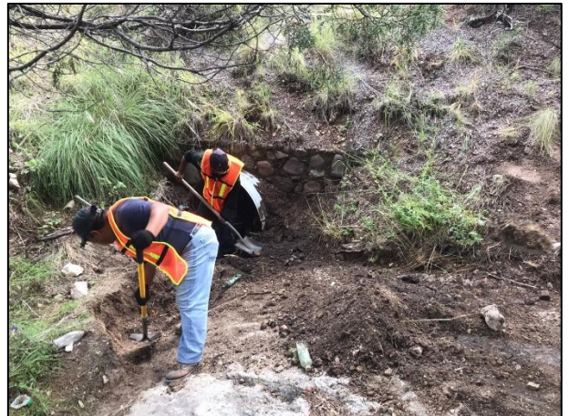
16 - Extracción del material edáfico afectado con Diésel llevada a cabo en las Zonas afectadas del sitio.
