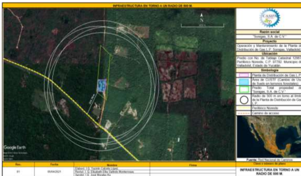
Figura II.14. Infraestructura en Torno a un Radio de 500 m.
