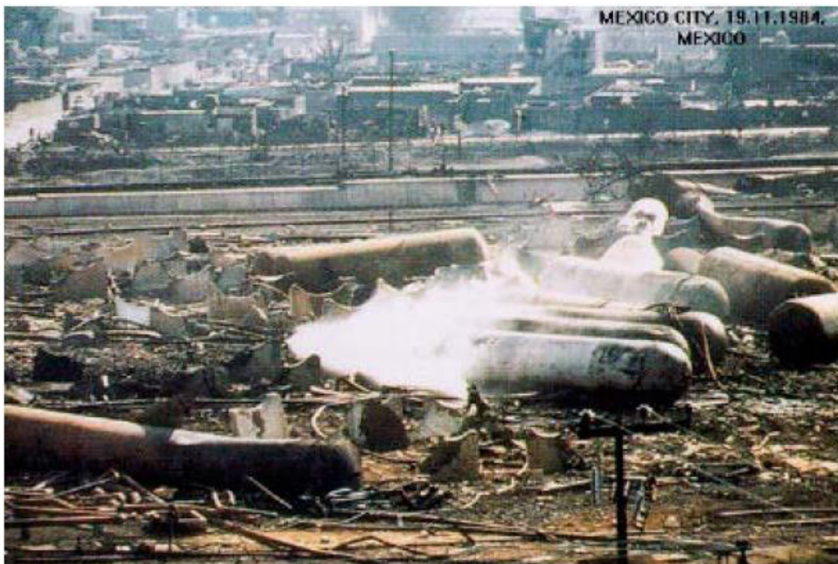
Figura 37. Resultados del incendio y explosión de contenedores de gas LP en San Juan Ixhuatepec, México, el 19 de noviembre de 1984 (Tudelft, 2001)
