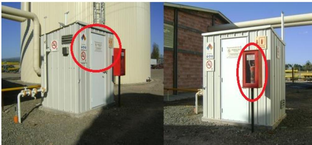
Figura X.30. Ejemplo de colocación de extintor y señalamientos de seguridad
