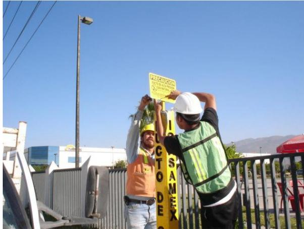
Figura X.44. Fotografía ilustrativa de colocación de poste de señalización tipo, de concreto armado.
