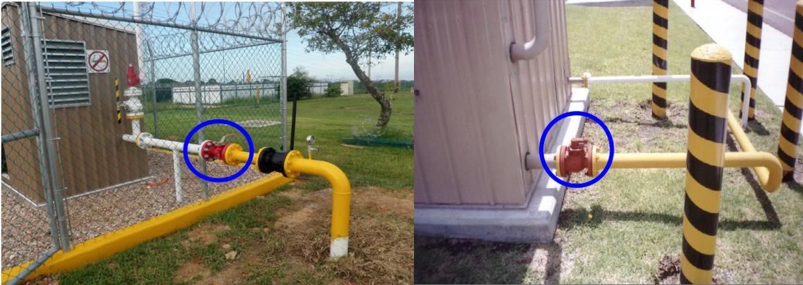
Figura X.31. Ejemplo de brida donde termina la construcción responsabilidad de CONSUMIDORA INDUSTRIAL OTAY
