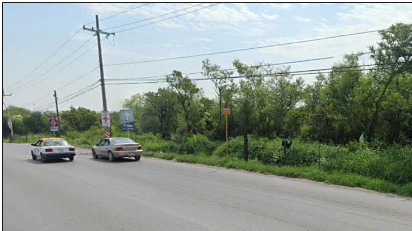
Figura 1. Vista panorámica de las actuales condiciones del predio, sobre Carretera a San Mateo
