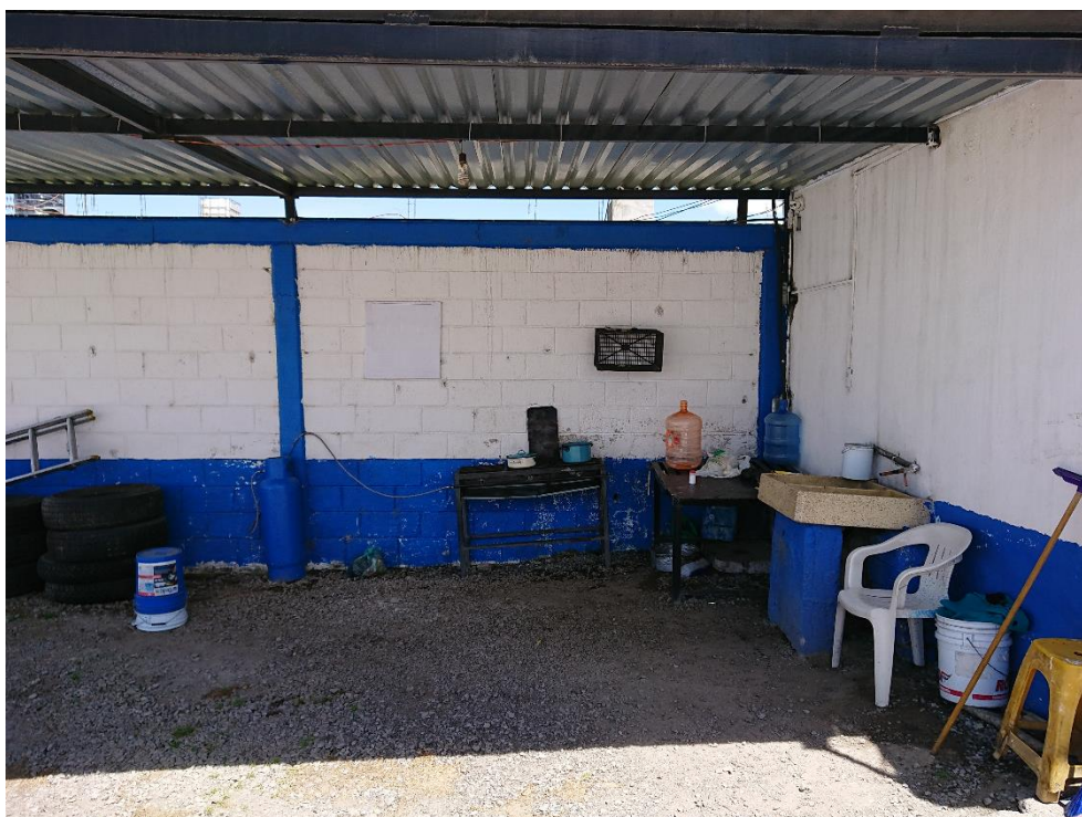
Ilustración 30. Pequeña lamina cobertor al lado del edificio existente
