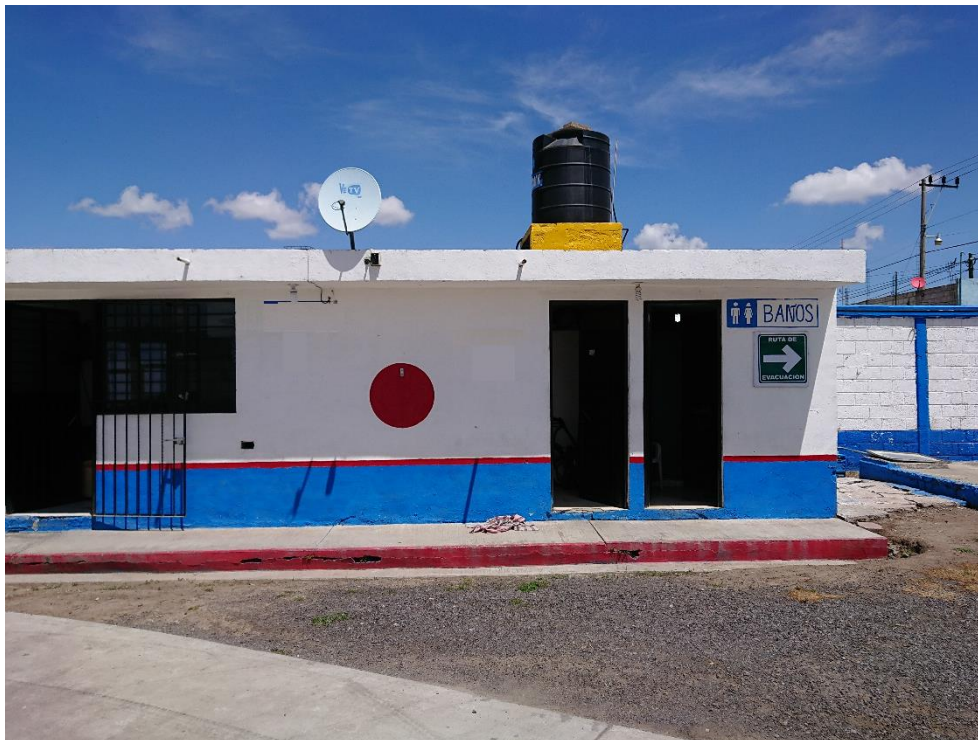
Ilustración 29. Edificio que será usado, como oficina, ya cuenta con un sanitario fijo
