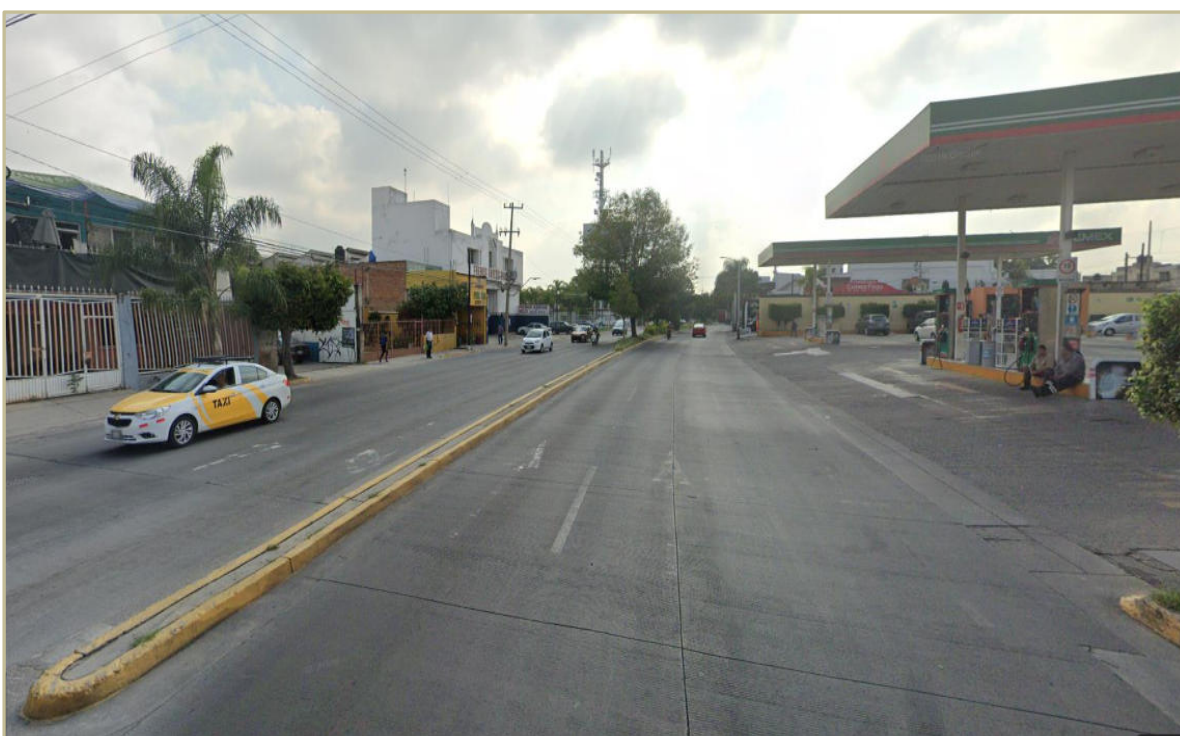
Vista de la Avenida Río Nilo, en donde se aprecian los cuerpos viales con los que cuenta, así como banquetas y alumbrado público.
