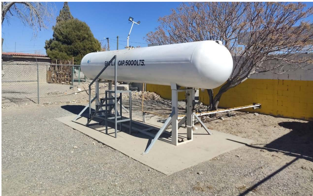
Foto 4 Vista del área de almacenamiento en donde se ejecutaran las obras y actividades para la instalación de un nuevo tanque..
