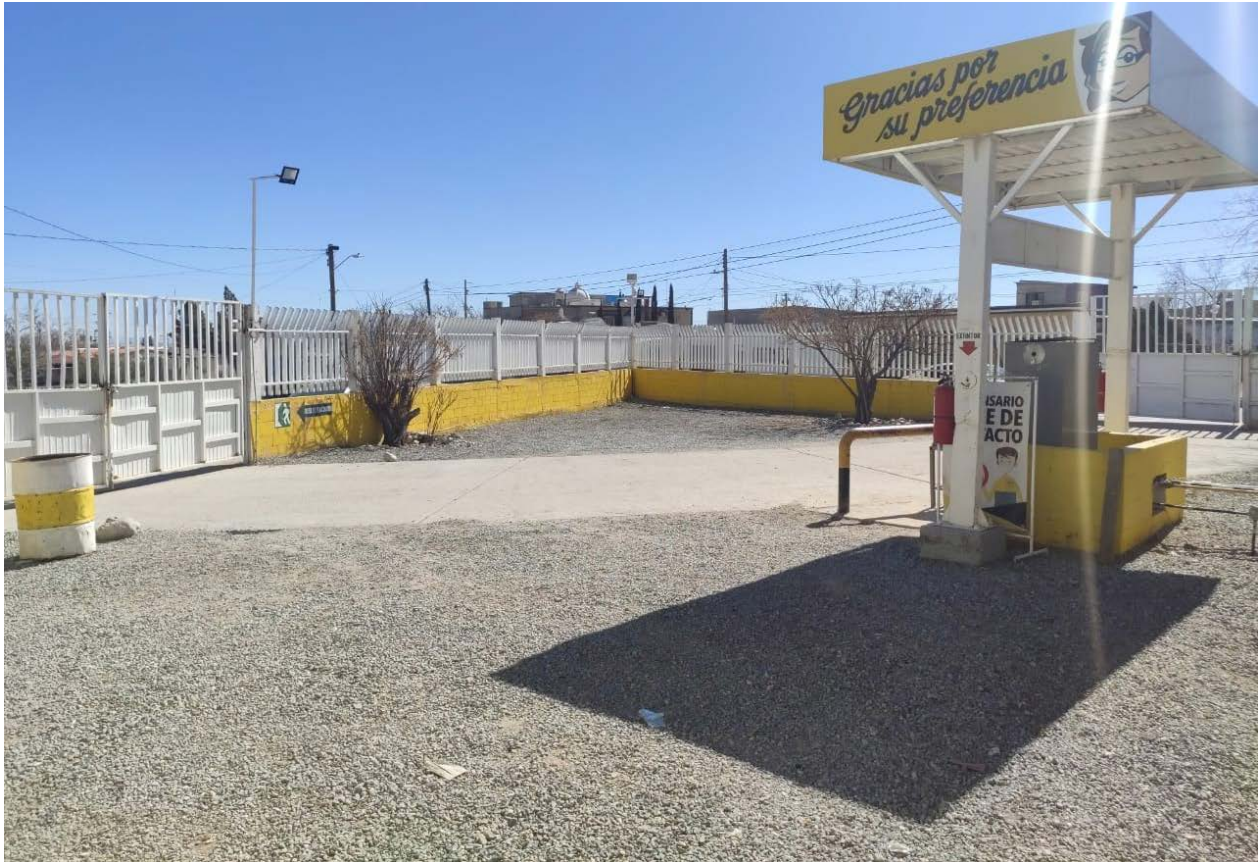
Foto 5 Vista del área del área de la isleta de suministro.
