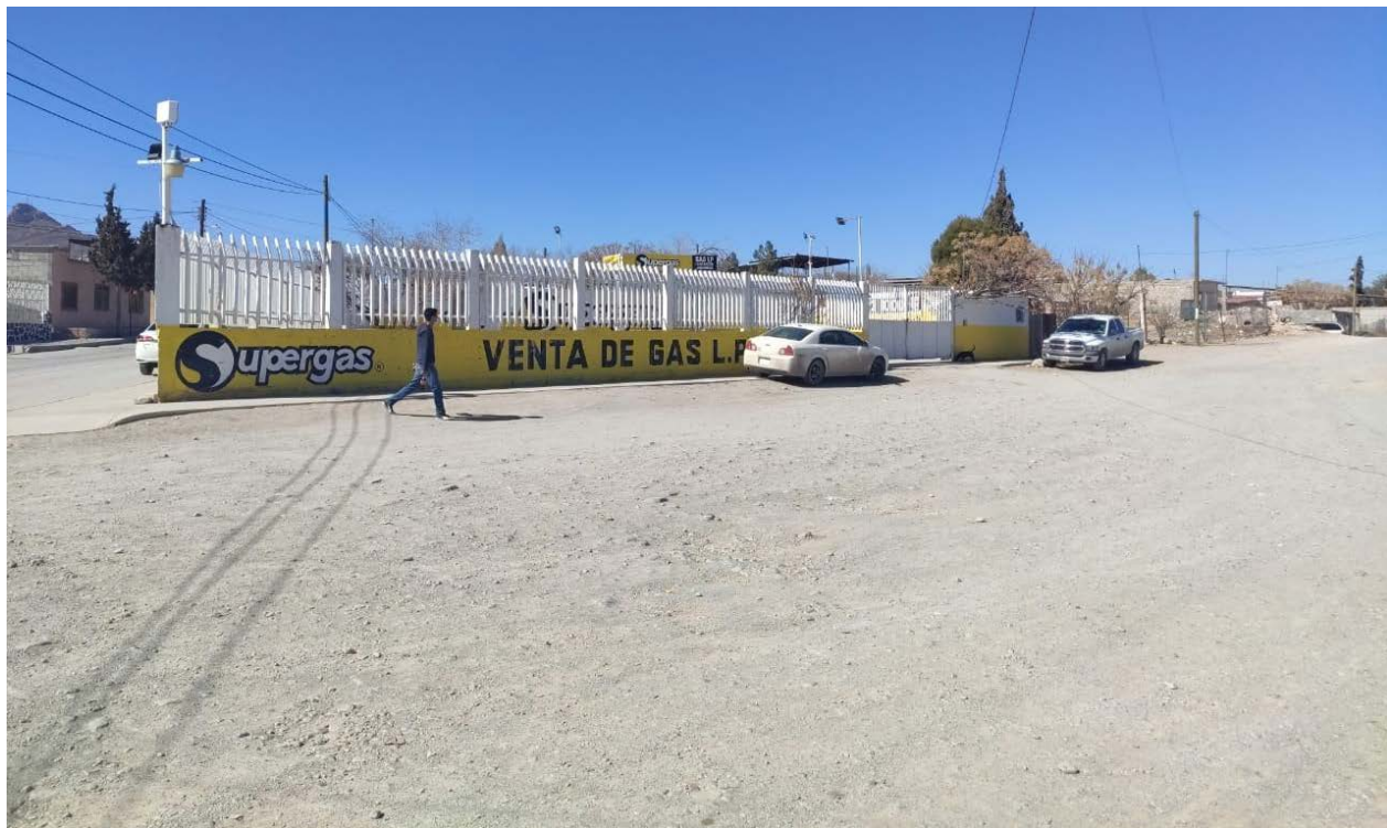
Foto 1 Vista General de la Estación Casa Janos desde la calle Batalla de Zacatecas. El interior del predio se encuentra totalmente compactado y cubierto de gravilla.
