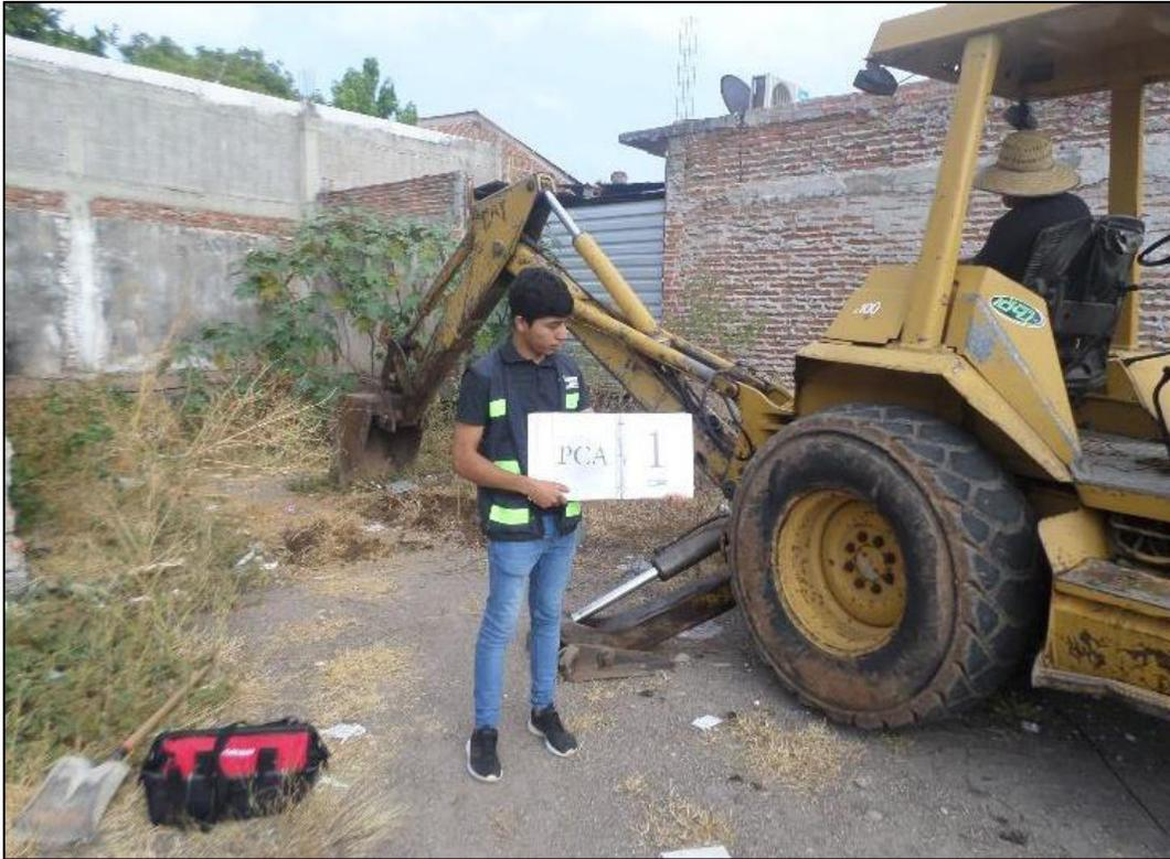
Fotografía 6. Realización del Pozo a Cielo Abierto PCA #1.
