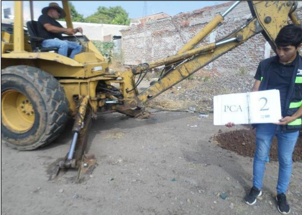
Fotografía 8. Realización del Pozo a Cielo Abierto PCA #2.
